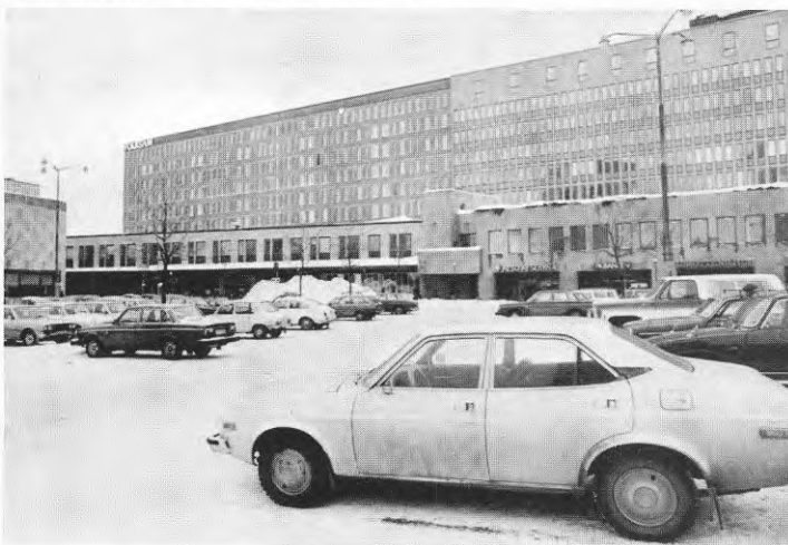
Figur 4.1 TermoDeck-byggnadens VSV-fasad (den vänstra delen av den långa, höga byggnaden)
