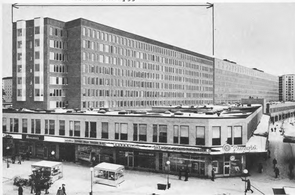
Figur 4.3 TermoDeck-byggnaden (Kv Storö 9) i Farsta
