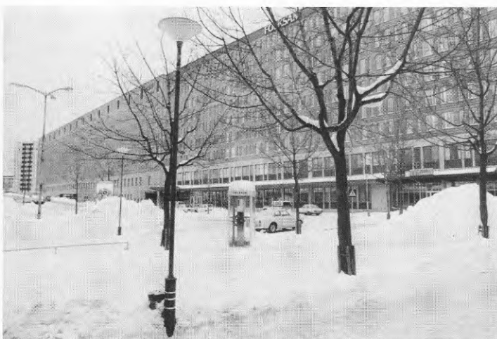
Figur 4.2 TermoDeck-byggnadens ONO-fasad (till höger på bilden)
