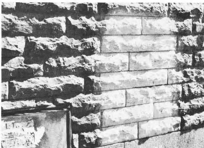
Figur 9. Efter ca 5 minuters recirkulation med rengöringsmedel B och sköljning med högtrycksspruta erhöles en helt ren kalkstensyta.
