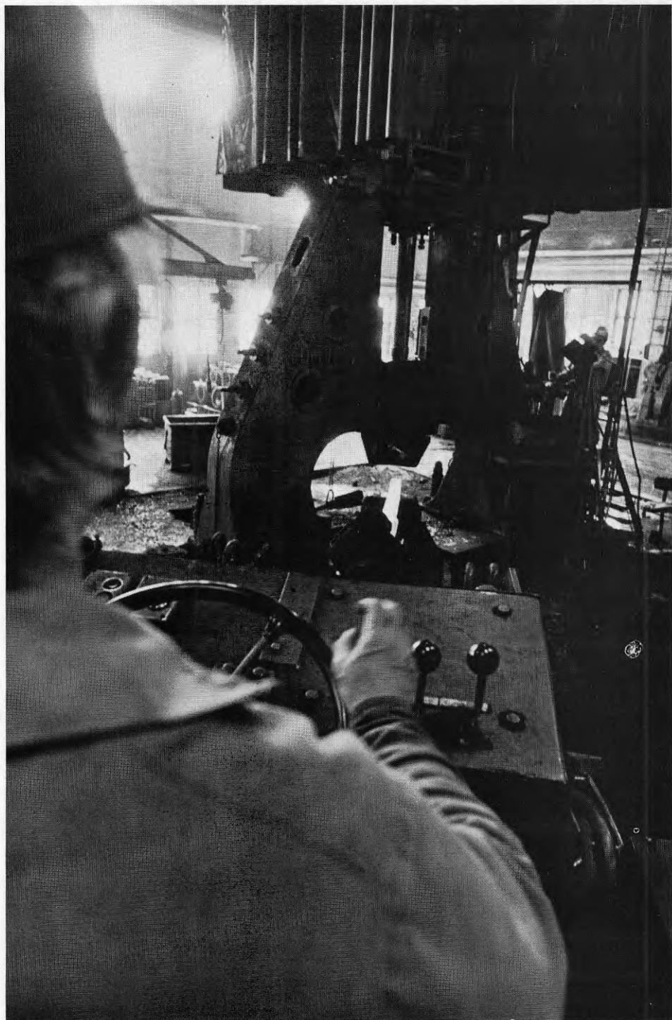
Tillverkning av fartygsventiler i smedjan i Vikmanshyttan
