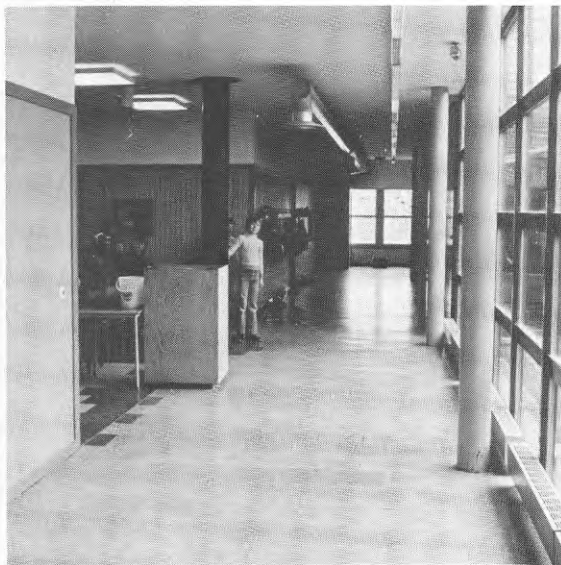
Bild 19.3. Vägghörn och pelare hade avvikande färg, vilket underlättar rumsupplevelsen för synskadade.
