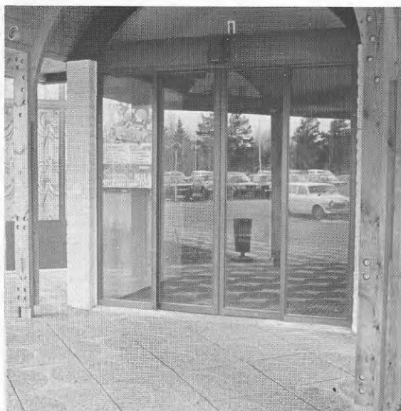
Bild 13.1. Bakgrunden speglades kraftigt i de omarkerade glasdörrarna. Speciellt för synskadade uppstår svårigheter att avgöra avståndet till dörrarna och att upptäcka om de är uppställda eller inte
