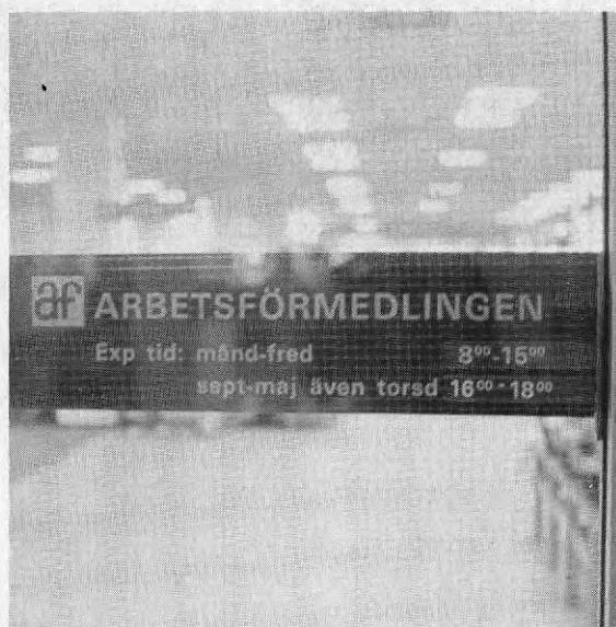
Bild 20.1. Arbetsförmedlingens upplysningsskyltar satt bakom trådglas. För synskadade uppstår svårigheter när man inte kan känna på texten och därför att glaset ger reflexer. Rörelsehindrade hade svårigheter att ta sig in då dörren var mycket tung.
