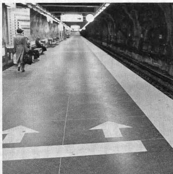
Bild 22.7. Perrongens kant hade markerats med ljusare material. För synskadade kan kanten därigenom lättare uppmärksammas. För blinda eller personer med balanssvårigheter kan emellertid risken för olyckor ändå vara stor.
