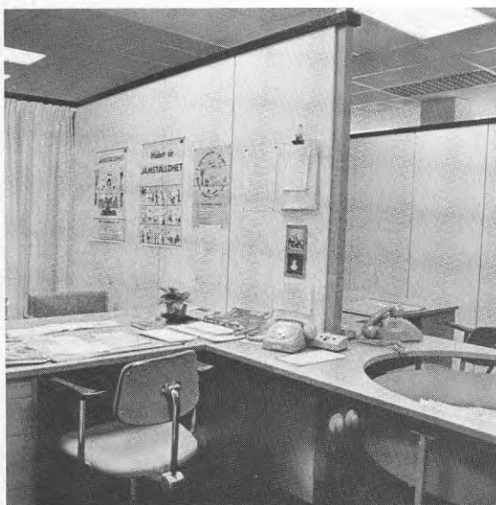
Bild 20.7. Vissa förmedlingsutrymmen var endast avskilda med en skärm. Ljudet mellan utrymmena avskärmades inte tillräckligt. Hörselskadade kan mer än övriga besvärmas av denna lösning.
