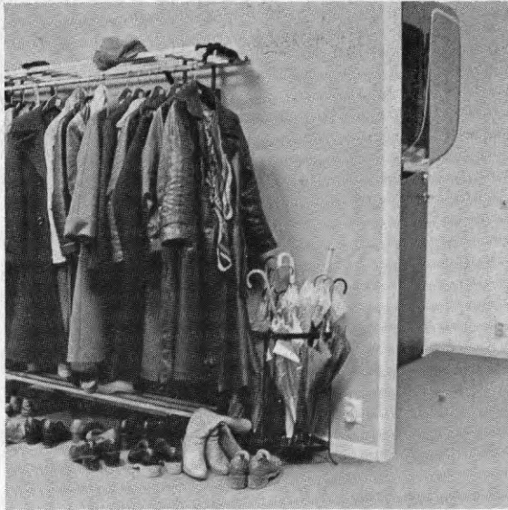
Bild 21.9. Kapphyllan hade oskyddade gavlar, vilket kan vara farligt för synskadade. Klädstången var för högt placerad för rullstolsbundna.
