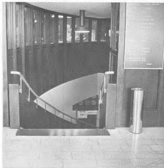
Bild 13.2. Denna trappa låg rakt innanför entrédörrarna. Trappan var visserligen markerad med avvikande färg i golvet, men risken är ändå stor att en orienteringshindrad person kan råka ut för en olycka här.
