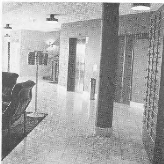
Bild 13.3. Pelaren var placerad i förflyttningssvägen mellan entrén och hissarna, vilket är olämpligt både för rörelse- och orienteringshindrade.
