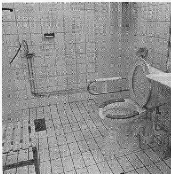
Bild 13.8. I de handikappanpassade duschrummen fanns en wc-stol med urtag för bidéfunktión. Den borde varit kompletterad med en handdusch inom räckhåll. Vissa tillbehör var placerade olämpligt för en rullstolsbunden.
