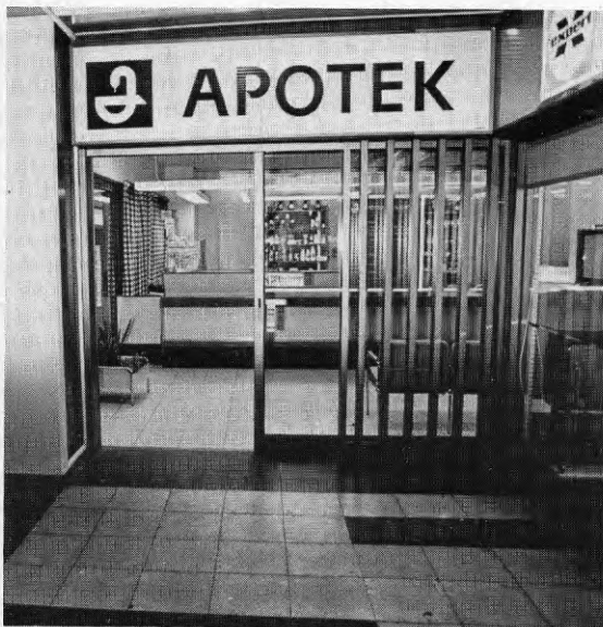
Bild 25.1. Entréen till apoteket hade en glasad skjutdörr. Rullstolsbundna är beroende av att det fria öppningsmåtten alltid gjordes tillräckligt brett. Skylten ovanför entréen var utförd med stora tydliga bokstäver vilket var särskilt värdefullt för synskadade.
