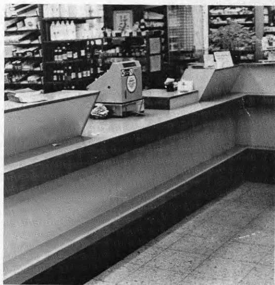
Bild 25.2. Inne i apotekslokalen var diskar höga utom vid kassan. Det lägre partiet underlättar för rullstolsbundna. Nummerlapparna satt för högt för att rullstolsbundna skulle kunna nå dem.
