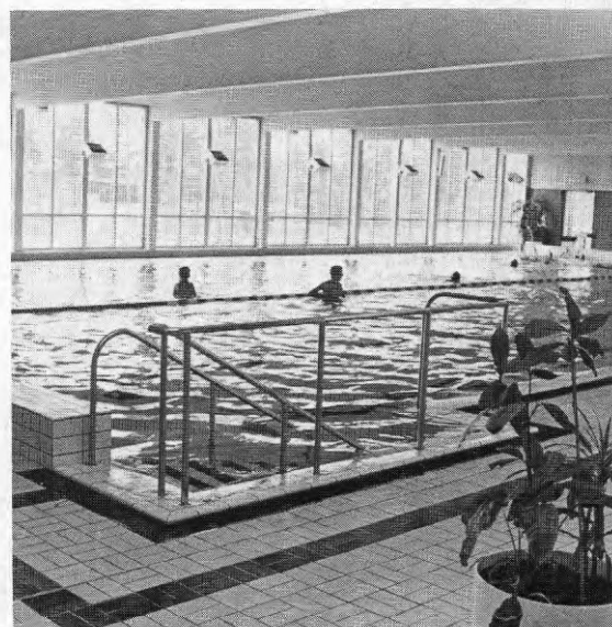
Bild 14.8. Simhallen hade en helt glasad fasadvägg. Det bildades bländande reflexer i vattnet, vilket kunde vara besvärande speciellt för synskadade.
