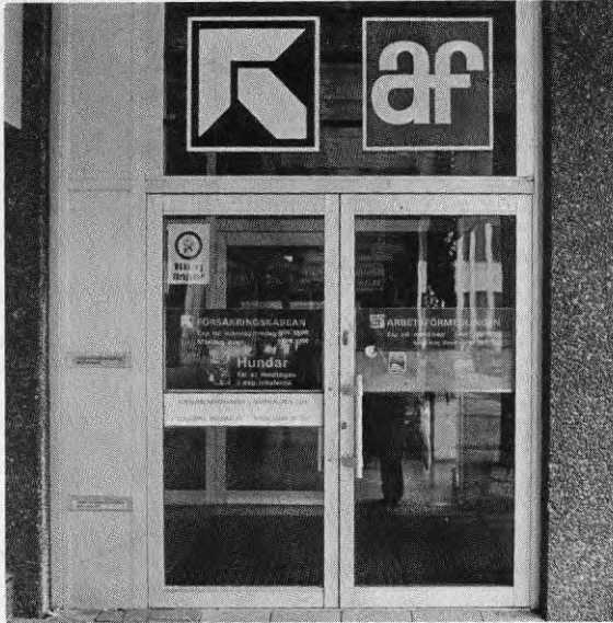
Bild 20/21.1. Skyltarna satt på entrédörrens insida. Texten var liten och glaset gav reflexer vilket innebär olägenheter för synskadade. För rörelsehindrade kunde dörrens tyngd vålla problem.
