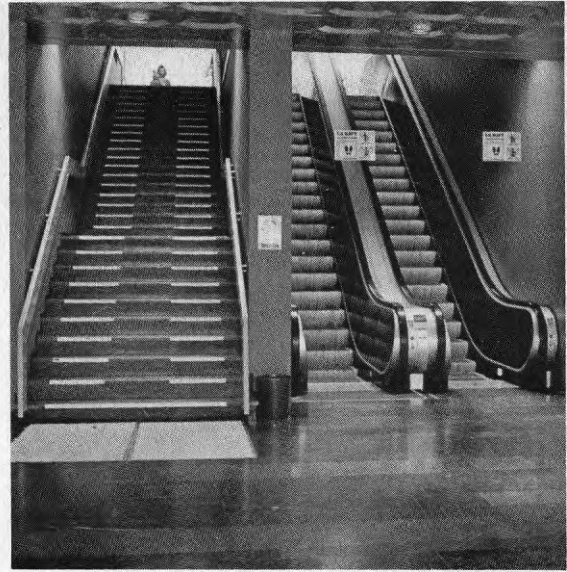
Bild 20/21.2. Golvet i entréhallen var halt vilket medförde halkrisk speciellt för rörelsehindrade. För synskadade hade trappan markerats med tejprensor. Ett mer permanent markeringsystem hade varit lämpligare.
