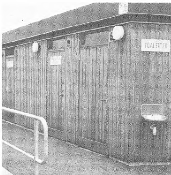
Bild 18.4. Handikapptoaletten, (dörren utan skylt), hade så hög tröskel att en rullstolsbunden person inte kunde ta sig in utan hjälp. Utrymmet var endast dimensionerat för manuella rullstolar.
