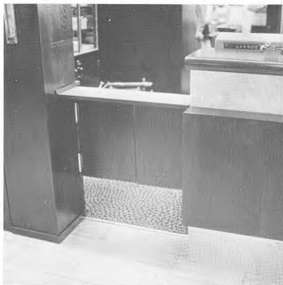
Bild 13.4. Receptionsdisken var anpassad för stående personer. Vid personalens passage fanns en skjutbar skiva på lämplig höjd för rullstolsbundna gäster.
