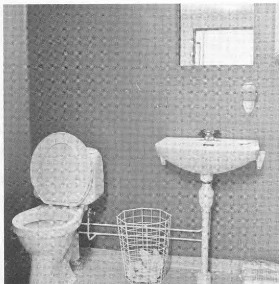
Bild 15.3. Handikapptoaletten saknade armstöd vid toalettstolen och larmanordning. Det fanns inget draghandtag på dörrens insida. Dessutom satt tillbehören för högt för rullstolsbundna.
