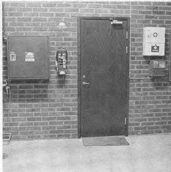
Bild 15.6. Förbandslåda, nöddusch-handtag och andra detaljer i verkstadslokalen kunde placerats lägre och därmed lämpligare även för rullstolsbundna.
