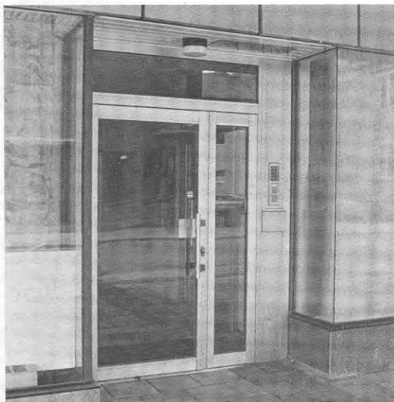
Bild 21.7. Personalentréen till försäkringskassan hade omarkerade glasdörrar, vilket är olämpligt för synskadade. Porttelefonen medför problem för hörselskadade och personer med talsvårigheter. Porttelefonen satt också för högt för att en rullstolsbunden skulle kunna nå knapparna.
