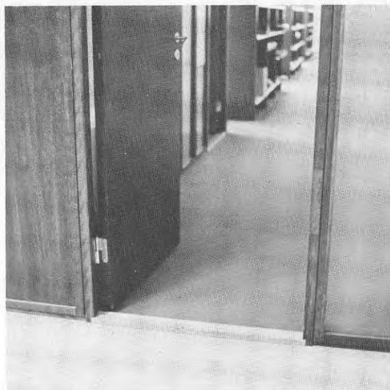
Bild 20.6. För en anställd som är rullstolsbunden medför kontorsrummens trösklar onödigt besvär därför att det är ofta återkommande hinder vid förflyttningen mellan rummen.
