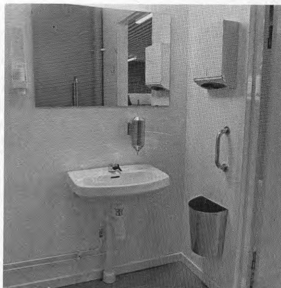
Bild 16.4. I skolans handikapptoalett försvårade papperskorgens placering möjligheterna för en person i rullstol att tvätta händerna. Muggar, pappershanddukar och spegel satt för högt och larmsystem saknades.
