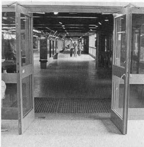
Bild 16.3. Dörrbladen hade samma färg som bakgrunden och var svåra att urskilja för en synskadad. Det kan medföra olyckor eftersom de inte står utefter en vägg i uppställt läge.
