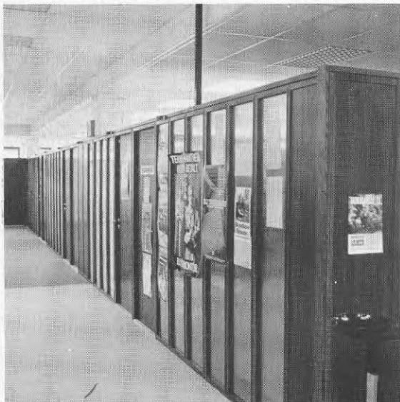
Bild 20.5. Kontorsrummen var uppbyggda med fristående väggar. Ljud avskärmades inte mellan rummen, vilket kunde medföra speciella svårigheter för hörselskadade.
