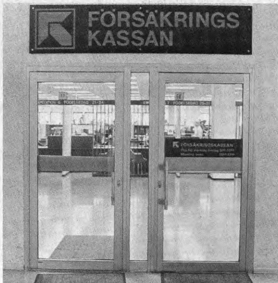
Bild 21.1. Försäkringskassans skyltar satt bakom trådglas och var - liksom arbetsförmedlingens - svår- lästa för synskadade. Även här var dörren tung och svår att öppna.
