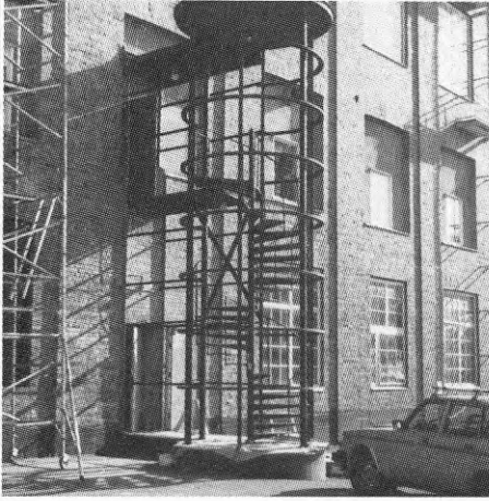
Norra fabriken: Den avskalade gjutjärnstrappan (ovan) och trappan färdig med ny klädsel (höger). (Foto: Torqny Törsäter)
