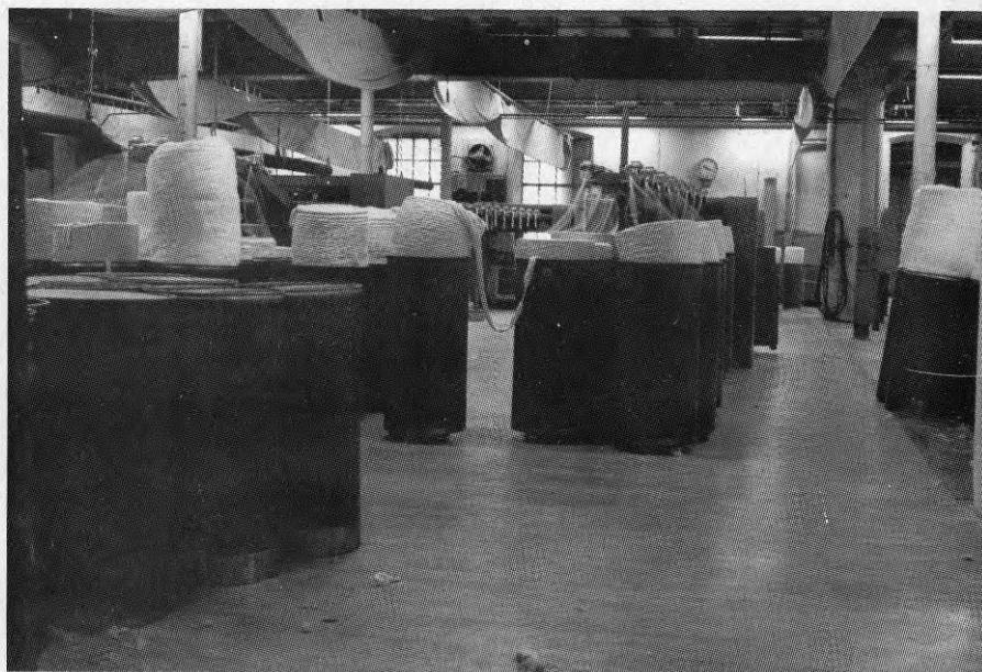
Ovan: Kardmaskiner på andra vån., Mellersta fabriken tillbyggnad. Nedan: Sträckning och förspinning gjordes på bottenvåningen i Mellersta fabriken huvudbyggnad. (Foto: Torleif Steinsson)
