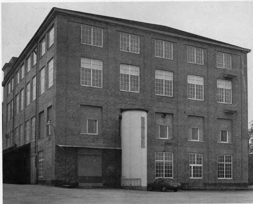
Norra fabriken sett från norr: Fasadens utseende vid spinneriets nedläggning. Gjutjärnstrappan är inklädd i korrugerad plast. (De små fönstren är ingrepp från Almedahls-epoken!) (Foto: Trad Wrigglesworth)
