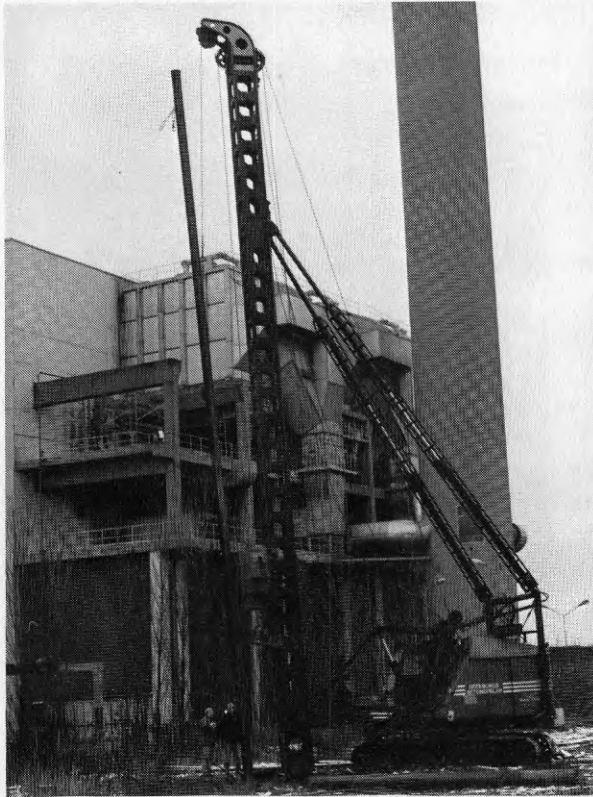
Figur 4.2 Neddrivningsförsök vid Sävenäs, Göteborg.
