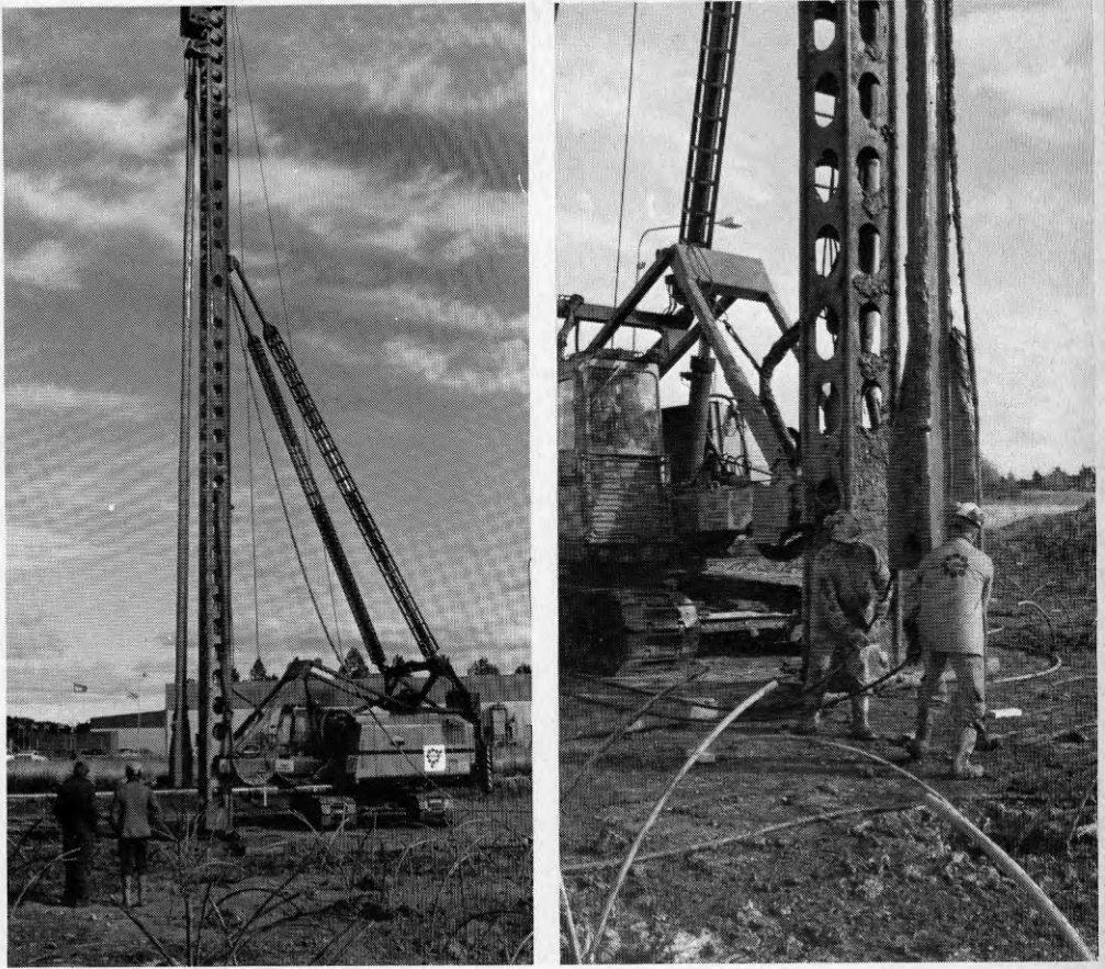
Figur 3.2 Bilder som visar olika moment vid neddrivning av dubbla U-rör.
