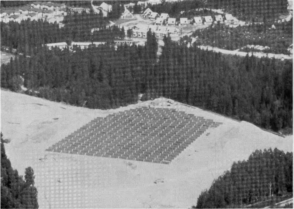
Figur 4.7 Solfångarfältet i Lyckebo (Uppsala) med 4320 m 2 solfångare i stora moduler.
