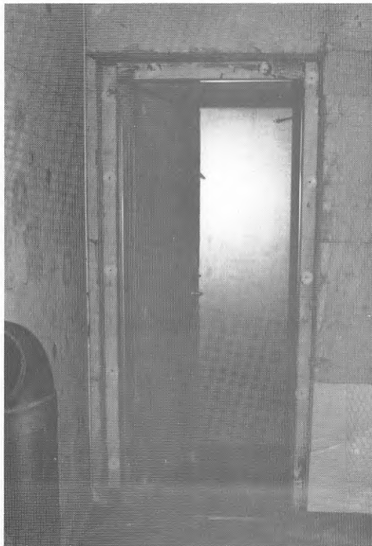
Figur b4.8 Isolering för ljuddämpning i förångarrummen.
