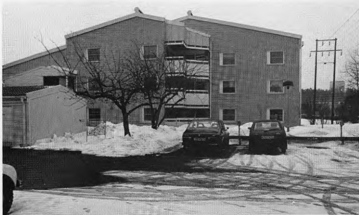
Södergården från väster. Till höger ses kraftledningen som går tätt in till husen.
