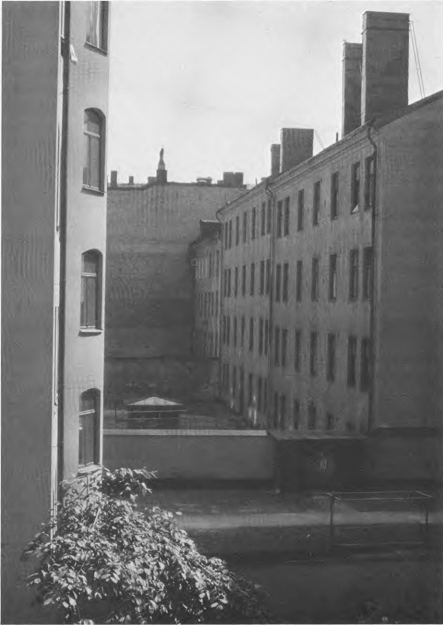
Fig 4.1 Stockholms stenstad. Västmannagatan i Vasastaden byggdes ut strax före sekelskiftet enligt det schema som 1874 års bygnadsstadga anvisade. Gathus i fem våningar, gårdshus i fyra våningar. Nettoexploateringen är hög e=2,0-2,5 .
