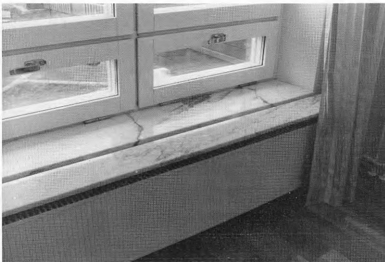
Figur 4.9 Vattenradiator i bostadsrum
