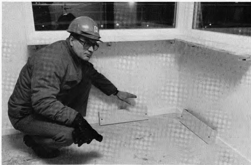
Bild 12:2 Tilluftsdon i lägenheter
