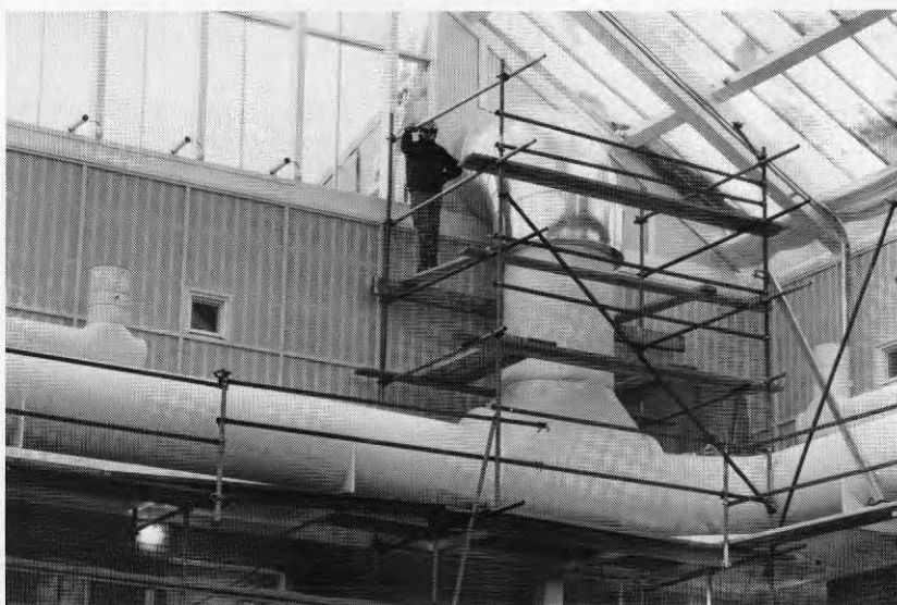
Bild 12:8 Cirkulationsluftskanalens anslutning mot fläktrummet
