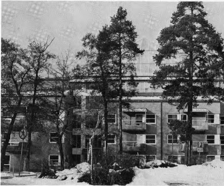
Fig 11:1 Fasad mot söder
