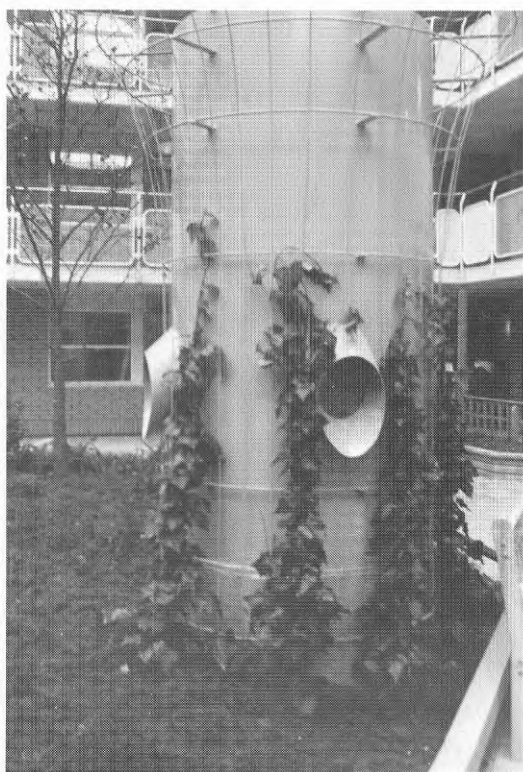
Fig 13:6 Cirkulationsskorsten på gården med luftinjekteringsdon
