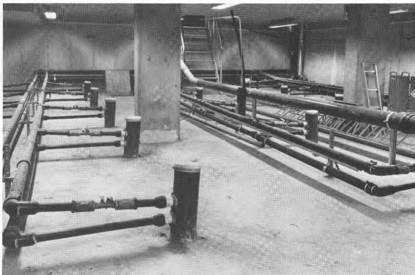
Bild 12:6 Borrhålslagret med anslutningsrör
