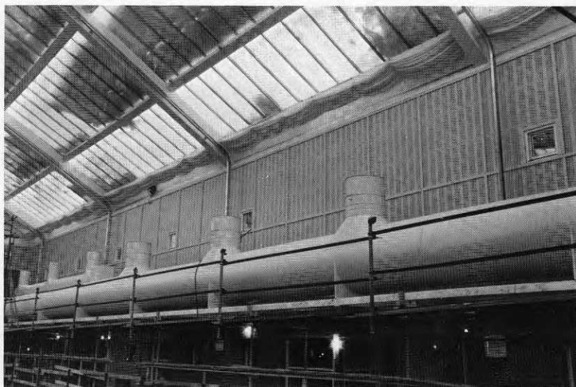
Bild 12:9 Cirkulationsluftskanalens placering på servicebryggan
