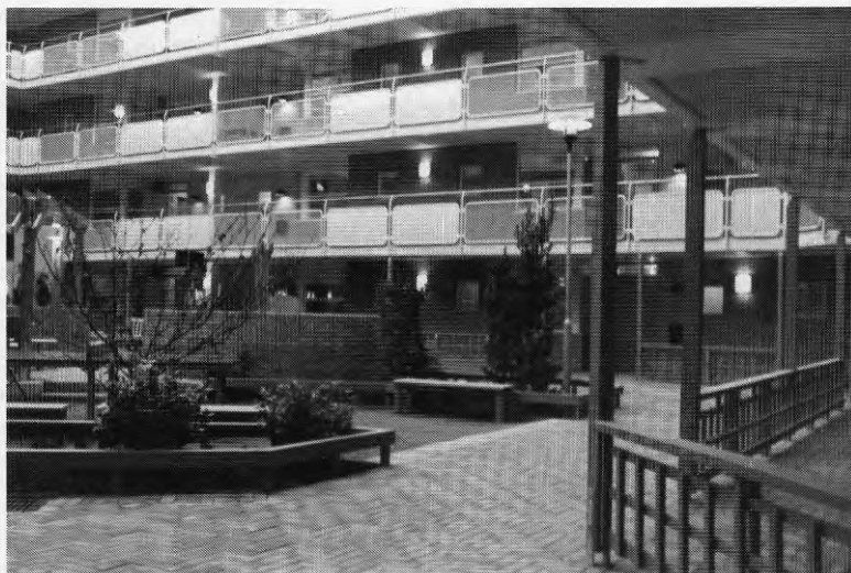
Fig 14:3 Gården sedd från en av entréerna - försedd med vindfång som hindrar kalldrag på växterna
