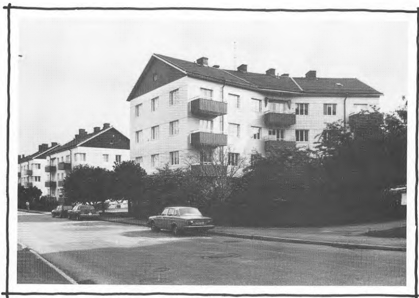
På gaveln till det böjda huset i södra delen av området finns tre butikslokaler
