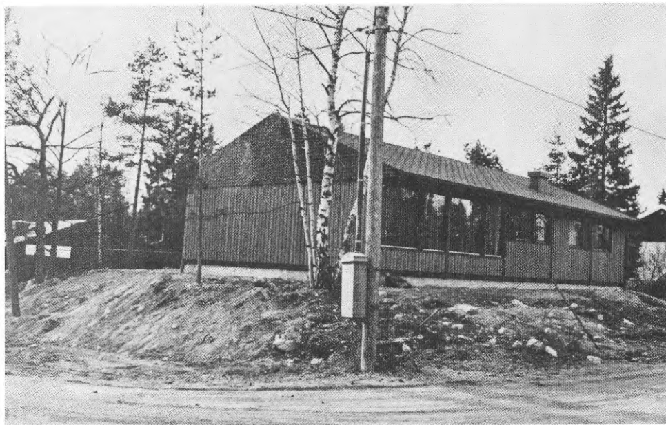
FIG 3 Exempel på byggarbetszonen vid styckehusbyggande.
