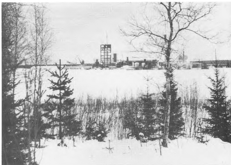
Koksverket, under uppförande, från Hertsöns strand
