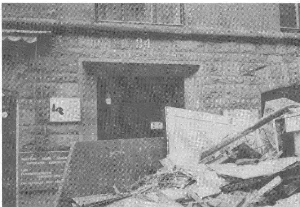
Fig. 9. Plötsligt står en container utanför porten och byggnadsarbetena har börjat i en tom lägenhet några dagar före julafton.
