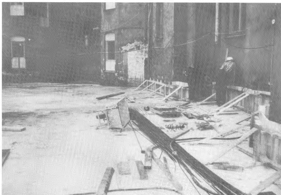
Fig. 17. Eftersom gården är underbyggd behövs en betongsockel för att klara vattenisoleringen på gården. Verkmästaren föreslår att sockeln ska gå upp 50 cm högt och täcka naturstenssockeln. Han tycker det ser snyggt ut för annars skulle naturstenssockeln synas lite grand.
