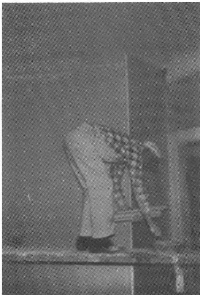
Fig. 18. I Ugnen 16 arbetade en stuckatör med att laga i såren i stucktaken. Dessa hade uppstått vid väggflyttningar, hissgenombrott och dylikt.
