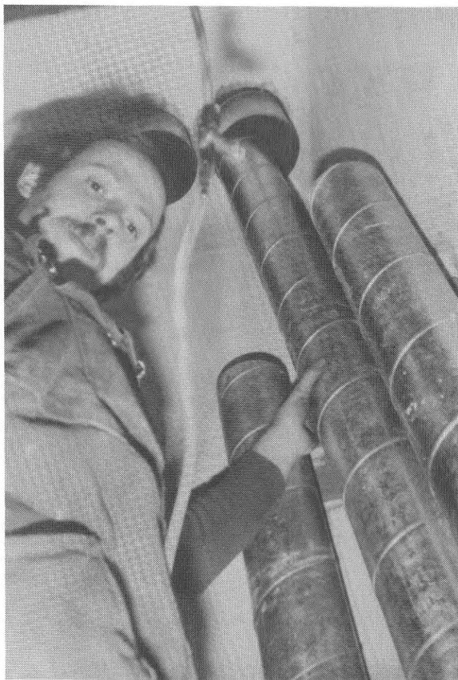
Fig. 14. Arbetarna får böja och bocka och passa in ventilations-trummorna i de borrade hålen. De arbetar ofta i trånga utrymmen, här i en liten garderob.
