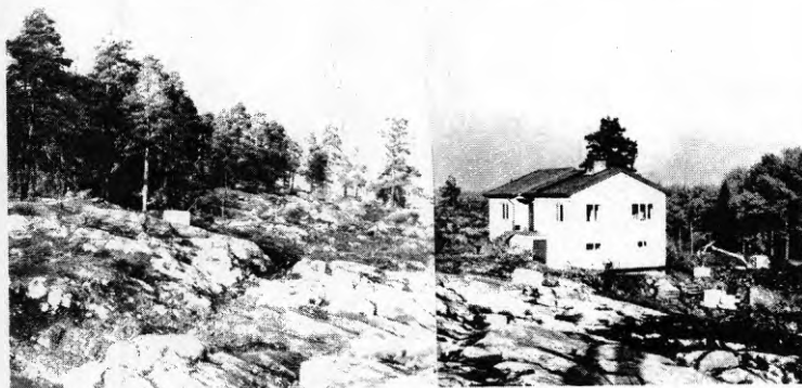
FIG. 1 Försökshuset av lättbetong i Älta utanför Stockholm
