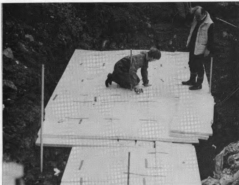
Foto nr 7. Tilläggsisolering av CBTK 600
