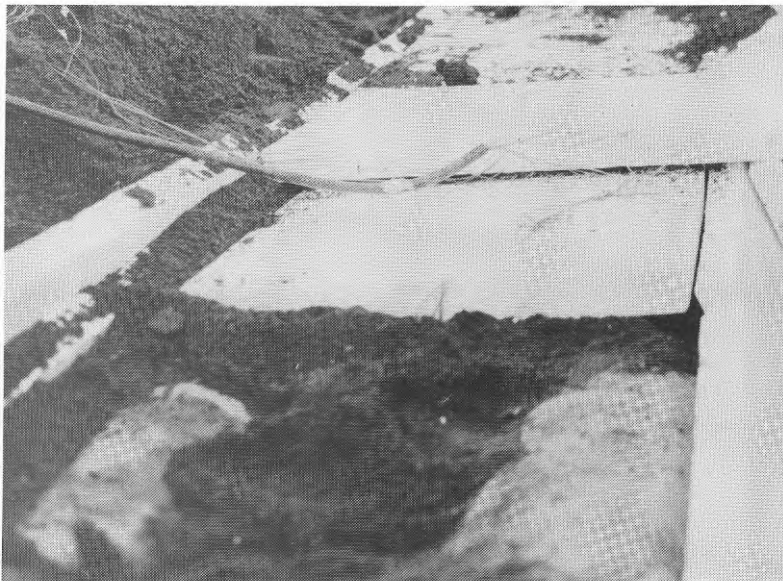
Foto nr 6 Tilläggsisolering av ACK 150/300
