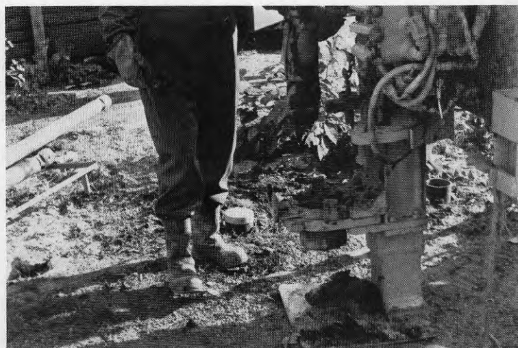
b) Foderrör med borrarordningarna under inpassning.
