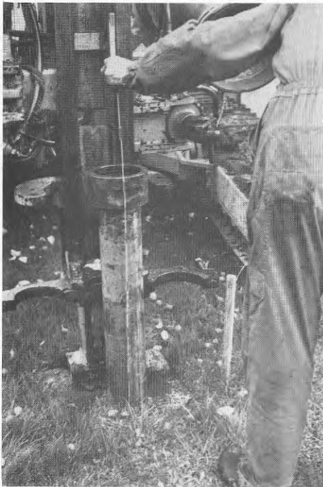
Figur 526 Nedborrning i marken av mantelröret med den inneslutna provfångaren. Kulturlagren tränger in och fyller ut provfångaren.
