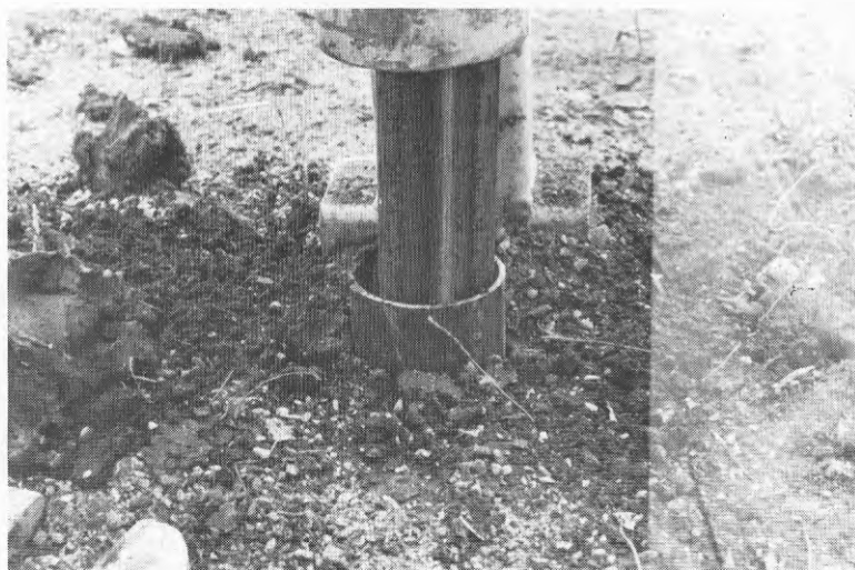
b) Genom foderröret slås en stålpåle utan att omkringliggande kulturlager störs.
