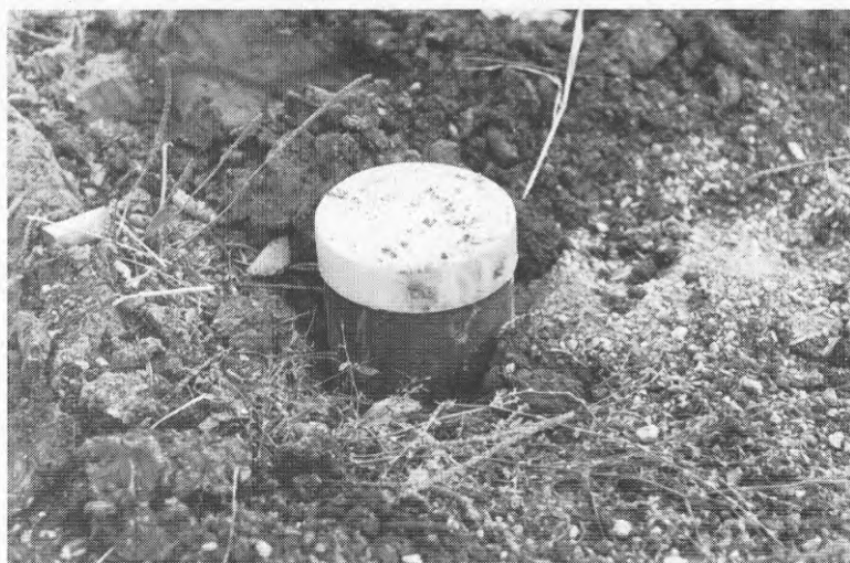
a) Foderrörets ovansida täcks med skyddshuv.
