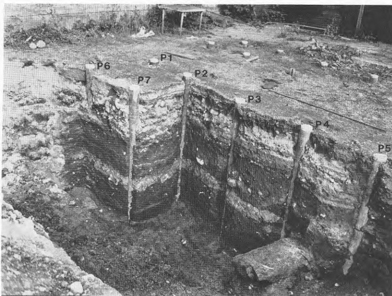
Figur 650 Vy av utgrävningsområdet med foderrören P2-P7 blottade.
