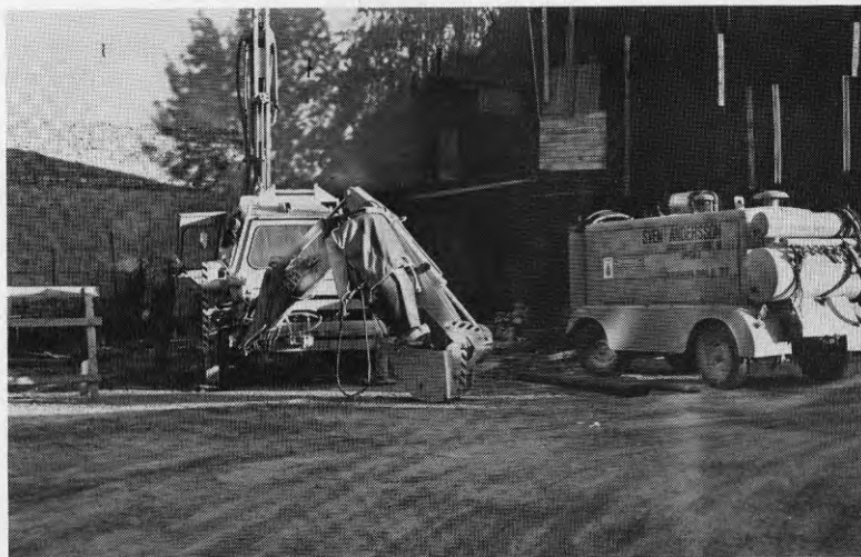
a) Arbetsanordningarna. Kran med grävaggregat och kompressor.
