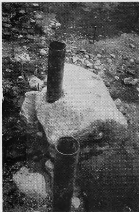
a) Foderröret har borrats igenom ett stenblock utan att rubba detta.
