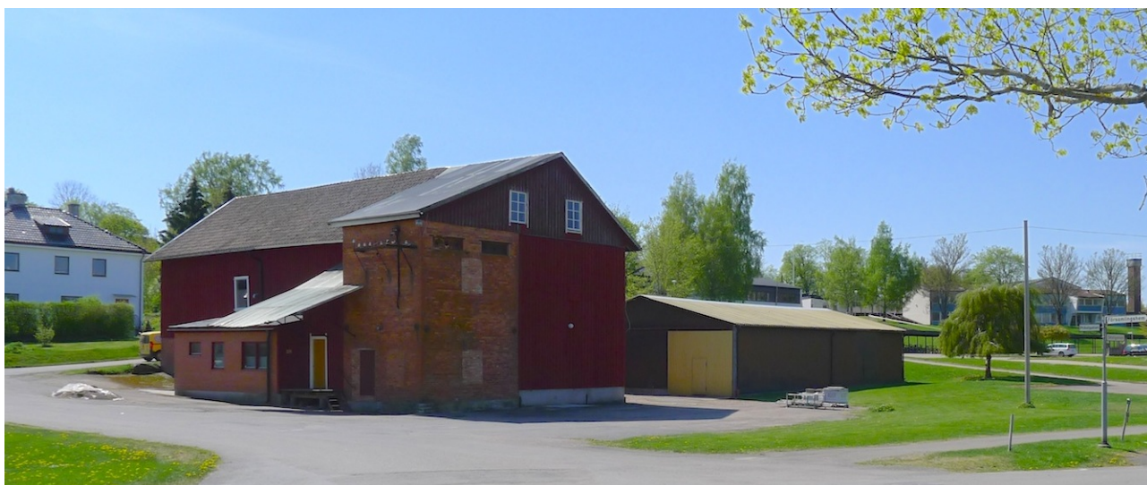
Fig. 26: Elverket som municipalsamhället tog över. Åns sträckning har lagts om senare. Foto: Winroth
