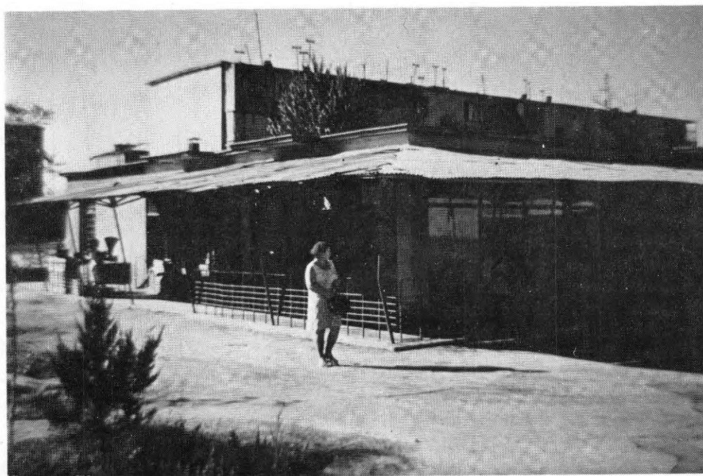
FIG. 2:4 Serviceblock i bostadsgrupp i Taškent. Byggnaden har uppenbarligen inte från början varit anpassad till den heta klimatzonen. De stora glaspartierna har i efterhand fått skyddas med ett skärmtak av korrugerad plåt.
