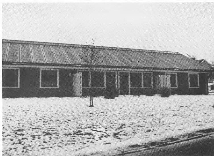
Figur 2.2 Hus D med solfångare åt söder
