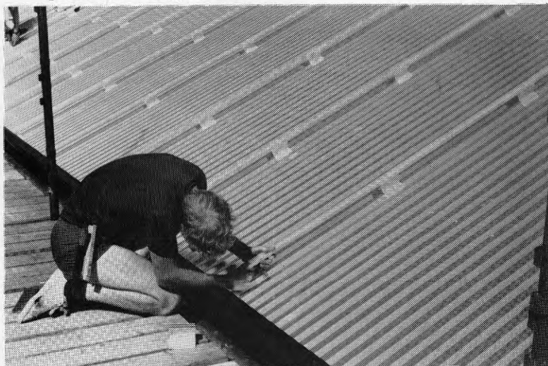
Bild 4 Montering av fäst- och spröjsprofiler.
