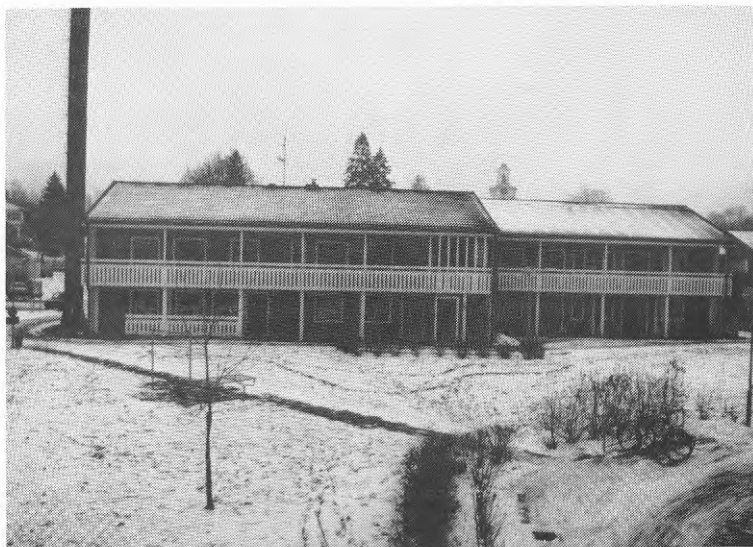
Figur 2.1 Hus B3 med värmecentral och solfångare åt väster och öster
