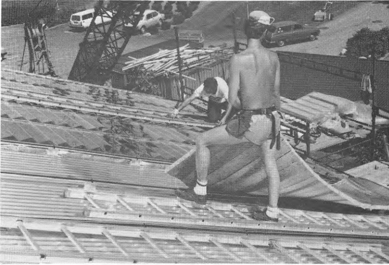
Bild 5 Utläggning av isolering.
