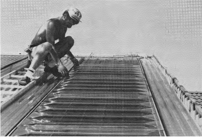
Bild 7 Utläggning av glastäckning.
