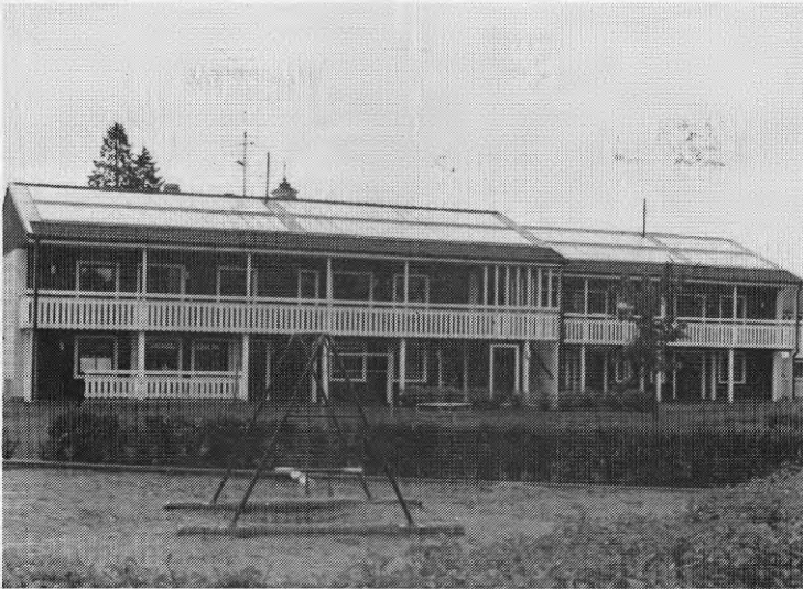
Bild 2 Hus B, solfångare (gamla typen) mot väster.
