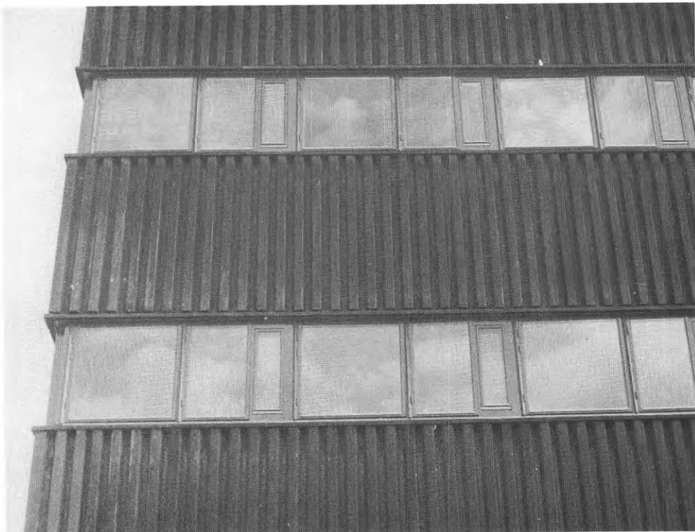
Bild 25. Fasaden är ur nedsmutsningssynpunkt väl uppbyggd. Profileringen i plåten leder vattnet jämnt och skuggspelet i den döljer föroreningarna.
