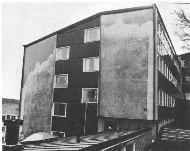
Bild 11. Endast den översta delen av fasaden har blivit fuktad. Denna del är, tillsammans med hörnen, även den renaste. Detta beror på, att det mycket sällan hinner utvecklas någon rentvättande vattenfilm över de övriga delarna av fasaden innan regnet upphör.
