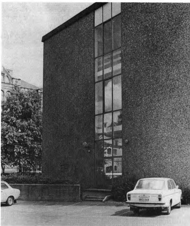
Bild 26. Vertikala fönsterband minskar nedsmutsningsproblemet. Regntvättningen blir effektiv, då vattnet kan strömma fritt efter glasytan.
