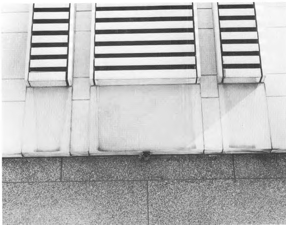
Bild 28. Ventilationsgaller monterade direkt på fasaden hindrar ett jämnt vattenflöde. Nedsmutsningsbilden utbildas därför snabbt på fasaden under dessa.
