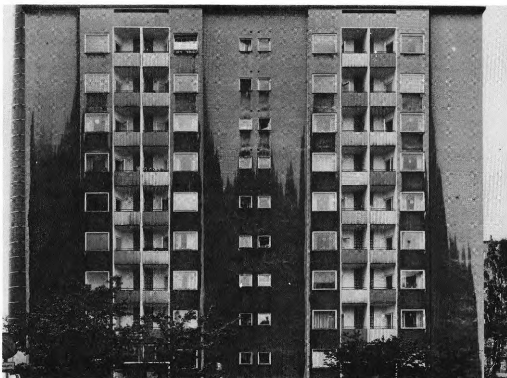
Bild 1. Typexempel på regntvättning av en fasad. Den taggiga övergången mellan rena och smutsiga ytor av fasaden beror på att vattenmängden över en plan yta har en tendens att rinna i koncentrerade flöden.
