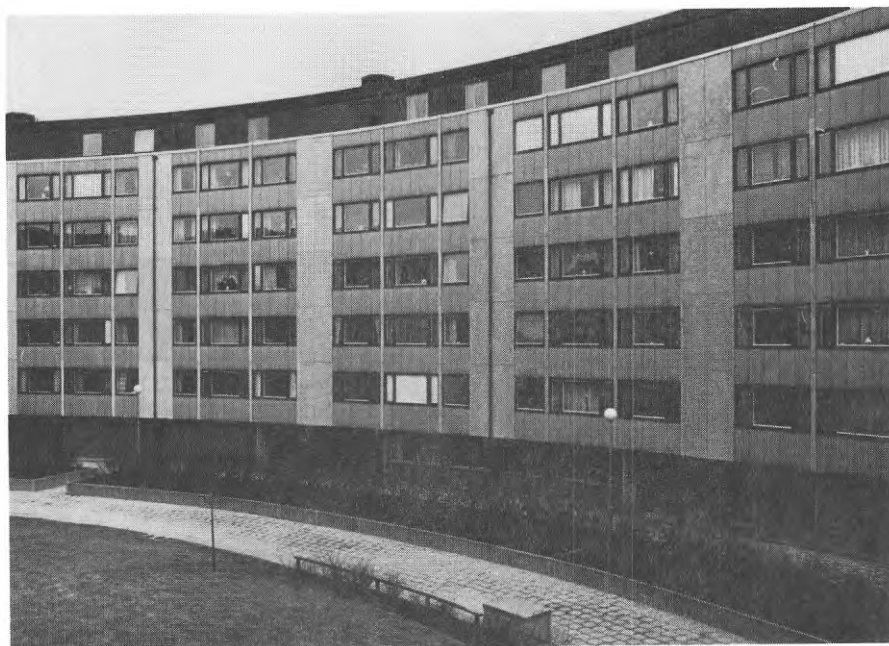
Bild 21. Denna fasad är väl genomförd ur nedsmutsningssynpunkt. Material med liknande egenskaper är placerade ovanför varandra och de översta och nedersta våningarna är indragna.
