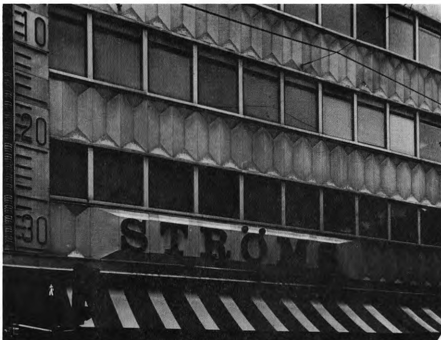
Bild 16. Plåtkassetter utformas lämpligen så att man får en samverkan mellan skuggor, nedsmutning och regntvättning i den mellersta zonen.
