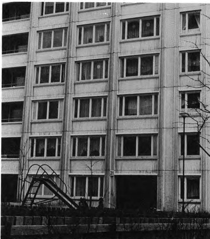
Bild 18. De kraftiga profileringarna i dessa fasadelement fungerar som rännor för vattnet, som rinner efter fasaden.
