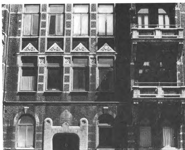
Bild 12. Den rika utsmyckningen av fasaden i den äldre putsarkitekturen är lycklig ur nedsmutsningsynpunkt. Skuggspelet gör, att intrycket av nedsmutsningen minskar. Vissa delar av fasaden nås sällan av regnvattnet och nedsmutsningen blir här relativt jämn, medan andra fasaddelar tvättas regelbundet vid regnväder.
