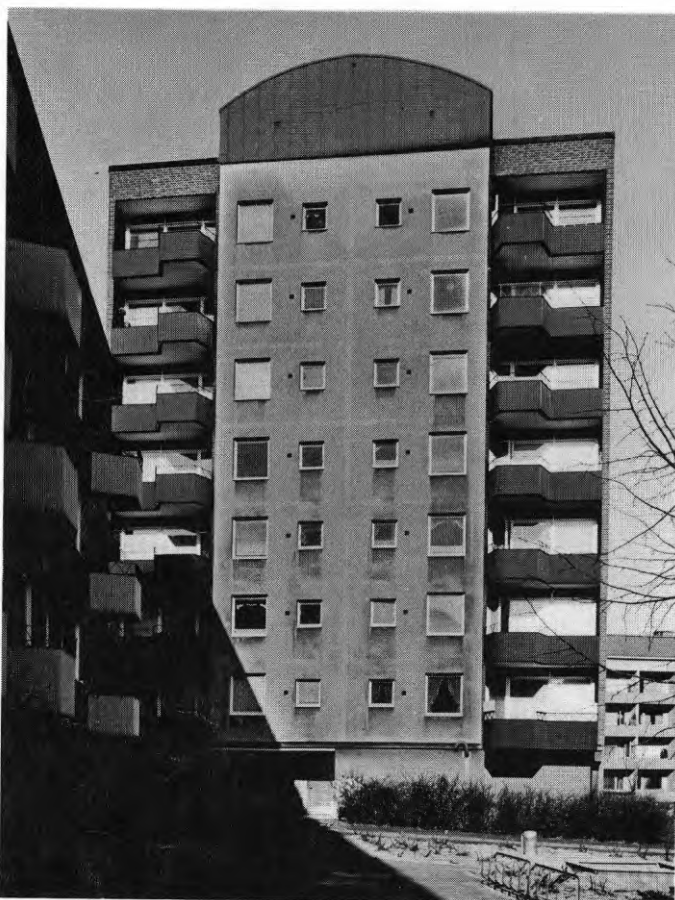
Bild 4. Byggnaden är skymd av trevåningshusen. De nedre delarna av fasaden tvättas i mindre utsträckning än på fasaden på bild 3. Anledningen är, att delningspunkten för vindströmningen flyttas högre upp genom störningen från de låga byggnaderna.
