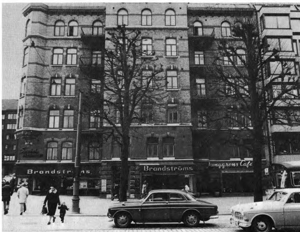
Bild 8. Fasaden träffas ej av slagregn i någon högre grad. Dammet, som avsatts på fasaden, stannar därför kvar. Speciellt på andra våningen är detta märkbart. Skyltfönstren i gatuplanet tvättas regelbundet.
