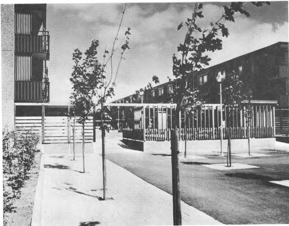
Bild 5. Den låga, relativt täta ytterstadsbebyggelsen innehåller ofta störningselement för vinden. Dessa ökar turbulensen och renodlade slagregnsriktningar utbildas ej. Regntvättningen av fasaden blir då jämn med små kontraster mellan rentvättade och smutsiga ytor.
