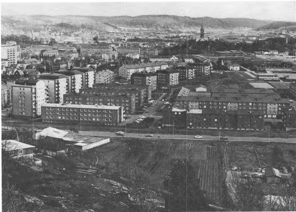
Bild 2. De fyra punkthusen till vänster i bilden skiljer sig från varandra enbart genom att byggnaden längst bort ej är skymd av trevåningshusen i den förhärskande vindriktningen.
