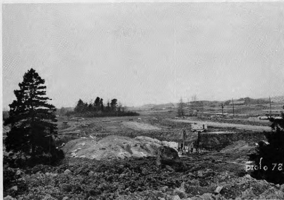
Figur 2 Området, lagret, före sprängning och schaktning. Observera granen till vänster som fortfarande står där.
