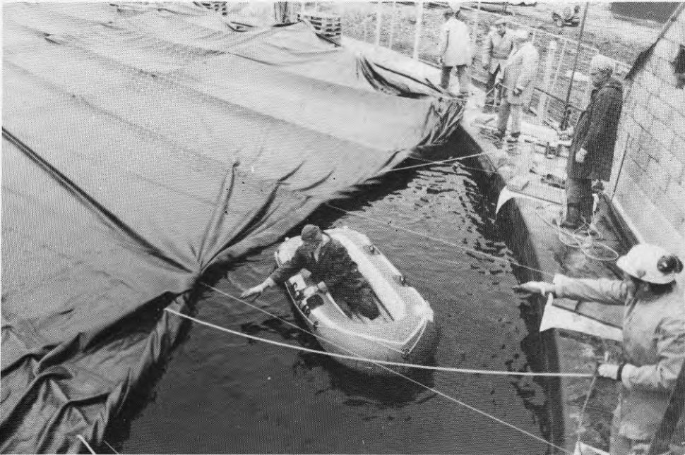
Figur 3.9 Livbåten användes vid montage av tätduk på lagret i Lambohov.
