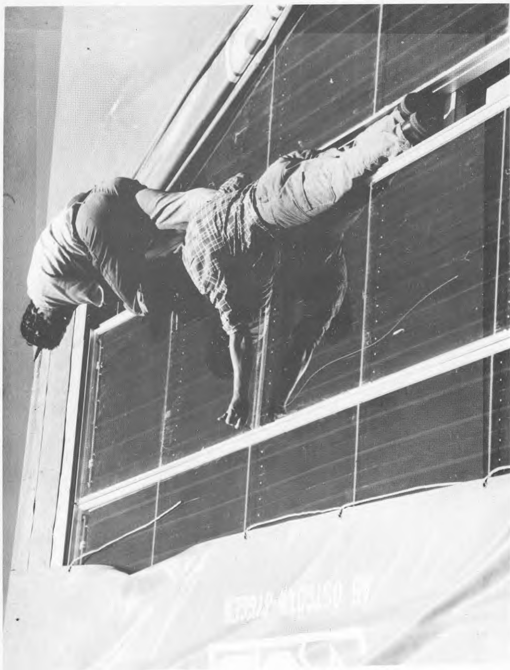
Figur 3.2. Fotot visar hur glasskivorna, 0,9 x 0,9 m, sammanfogade med silikongummi, lätt utbytes. Fotot liggande.
