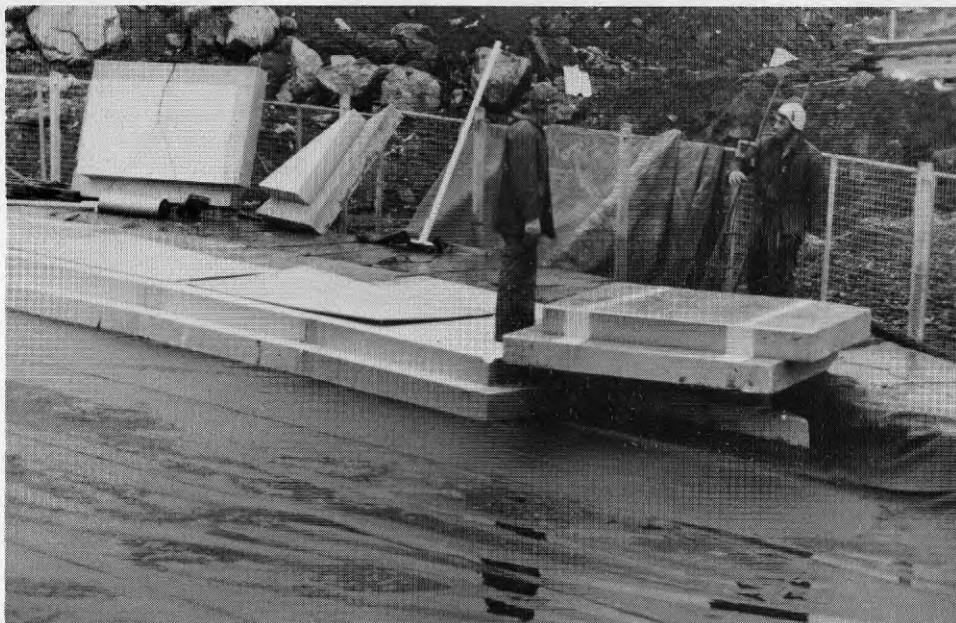
Figur 3.12 Utplacering av isolerblock på lagret. Blocken läggs direkt på butylgummiduken. Observera de omlottliggande kanterna.
