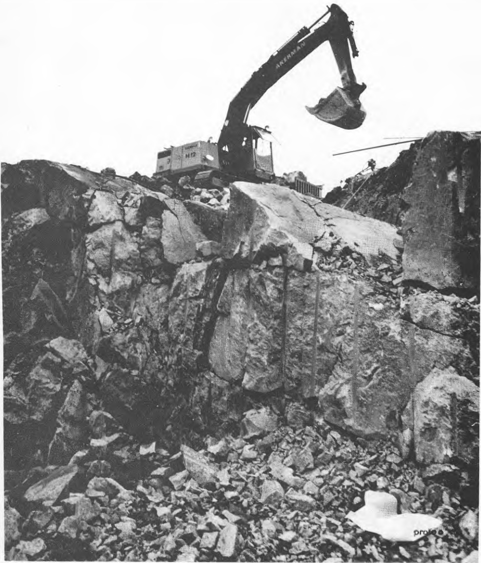
Figur 2.20 Bilden visar berget vid utschaktning för lager.
