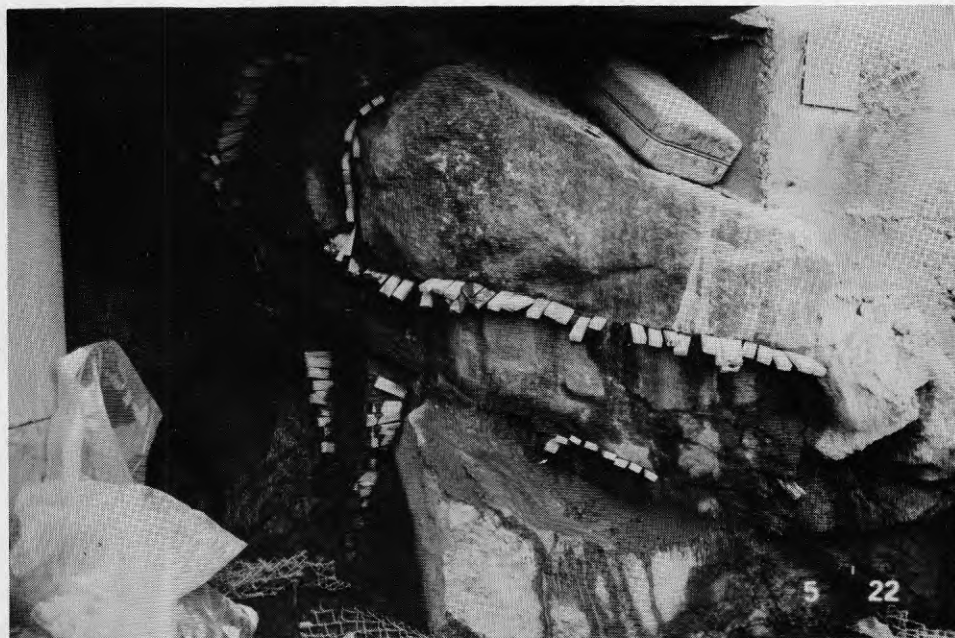
Figur 3 Sprickor i berg tätades med lin, träkilar och betong.
