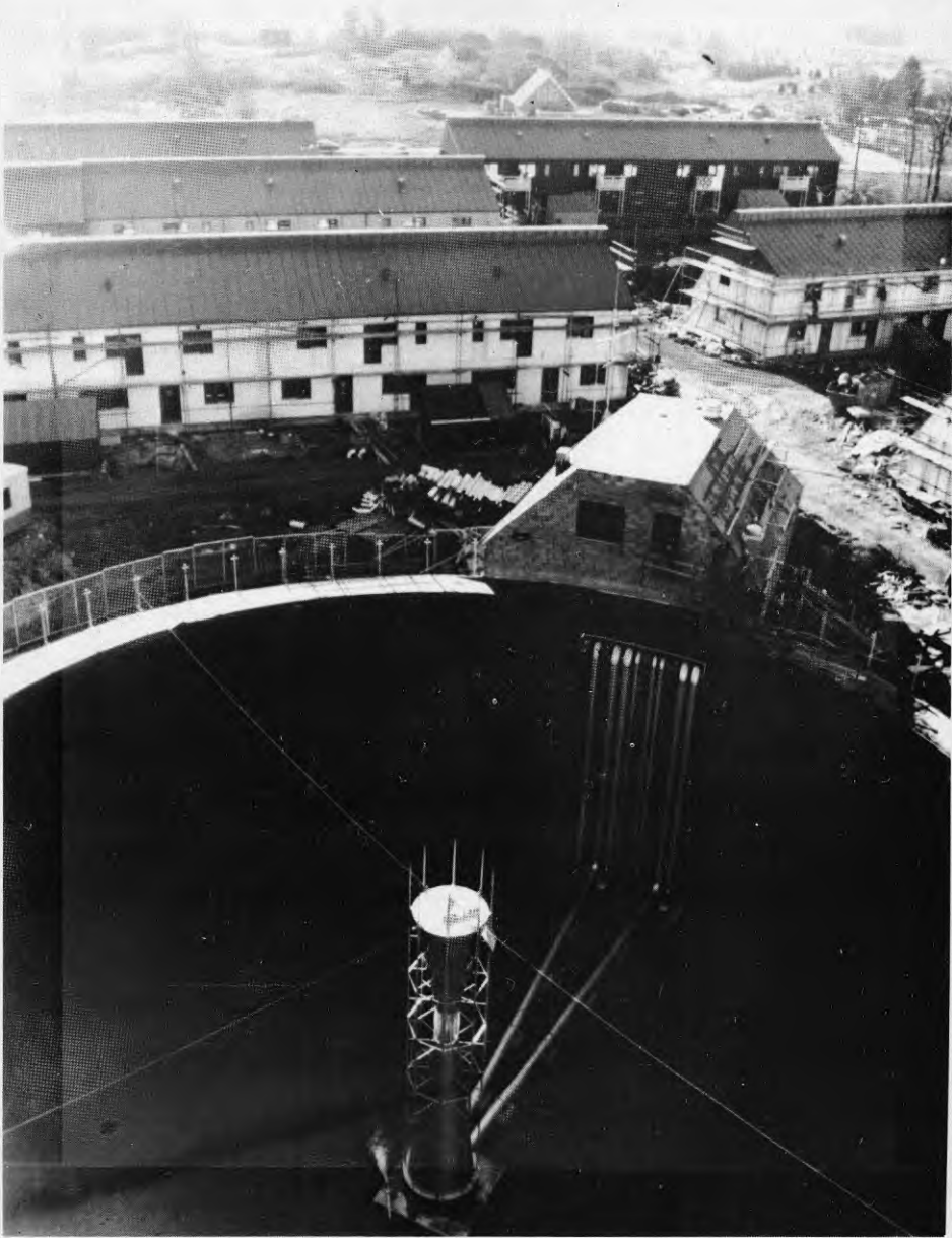
Figur 2.18 Fotot visar skiktfördelaren och dess anslutningar till lagret. Vattenfyllning oktober 1979.
