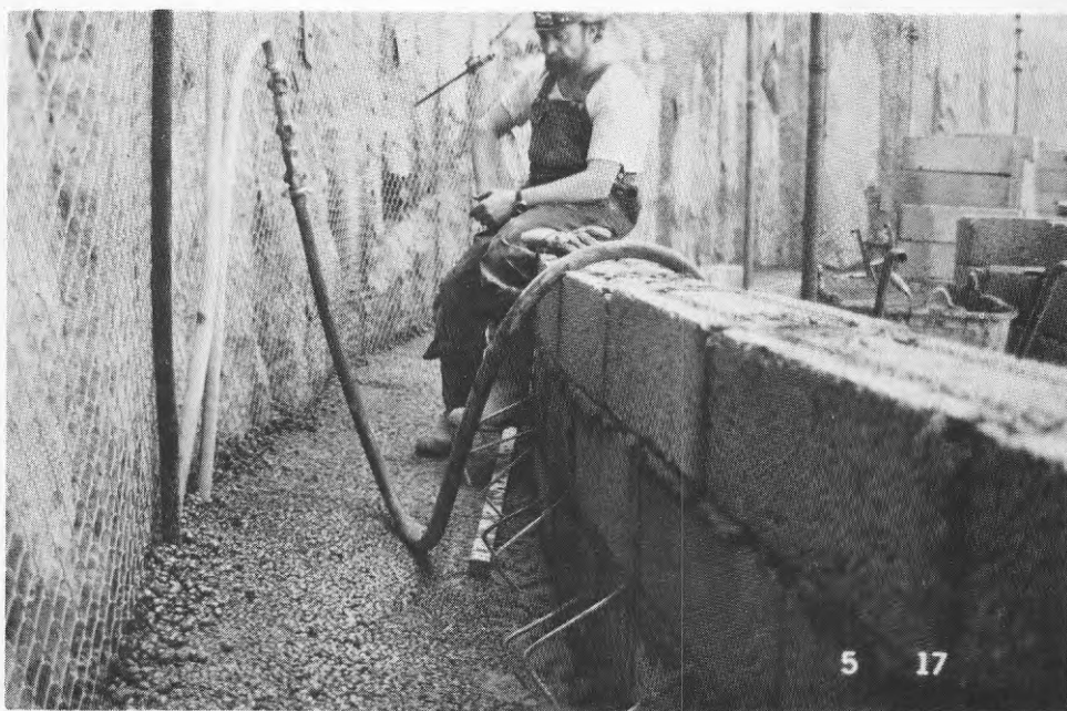
Figur 5 Efterinjektering.
