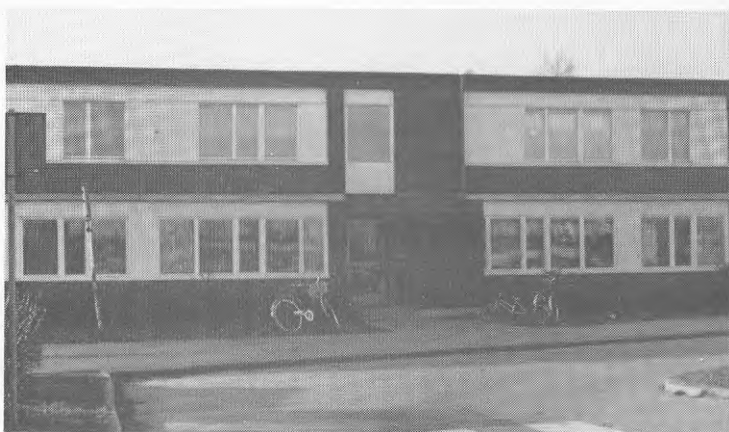
Figur 5.1.9 a. Vivalla. Fasad efter åtgärd, dvs nya fönster med mindre area i övervåningen.
