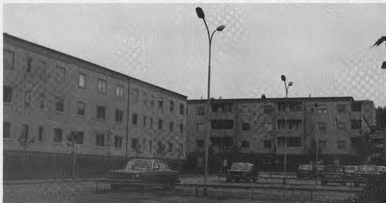
Figur 5.1.5 a. Bondegärdet. Fasad före åtgärd.
