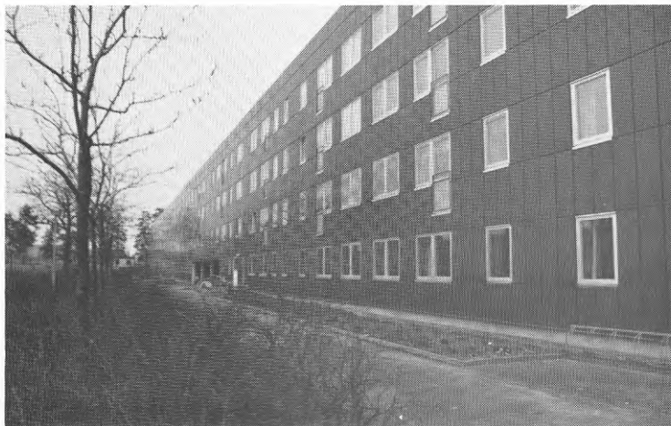
Figur 5.1.11 c. Fasad med nya fönster.
