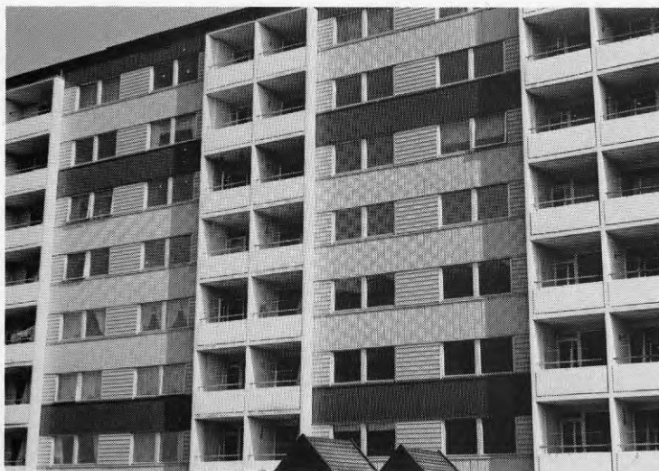
Figur 5.1.2 d. Fasad mot väster efter genomförd åtgärd.
