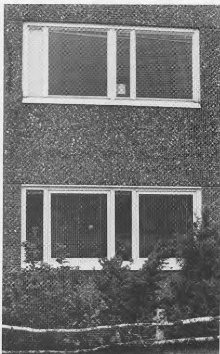
Figur 5.1.7 c. Del av fasad med nytt fönster i bottenvåningen.
