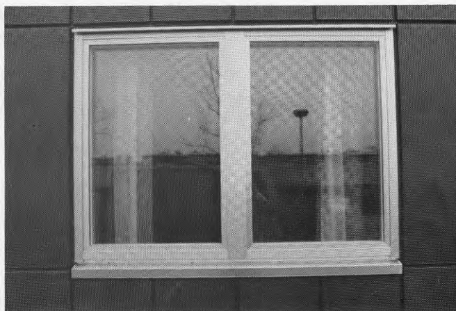
Figur 5.1.11 e. Nytt aluminiumbeklätt träfönster.
