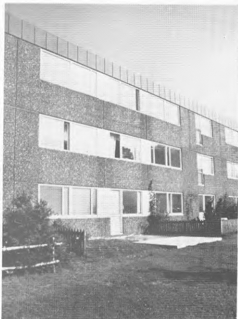
Figur 5.1.7 a. Oxled. Fasad före åtgärd.
