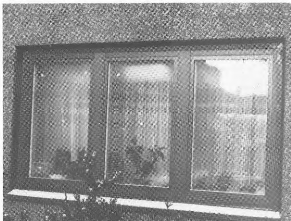
Figur 5.1.10 c. Nytt aluminiumbeklätt träfönster.
