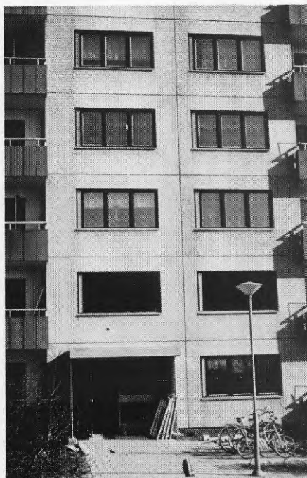
Figur 5.1.3 e. Del av fasad med de nya fönstren.
