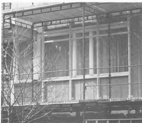
Figur 5.1.6 d. Reglarna för tilläggsisoleringen har monterats. Här syns tydligt skillnaden i storlek mellan de befintliga och nya fönstren.
