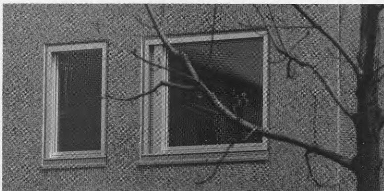
Figur 5.1.5 d. Fönster efter åtgärd.
