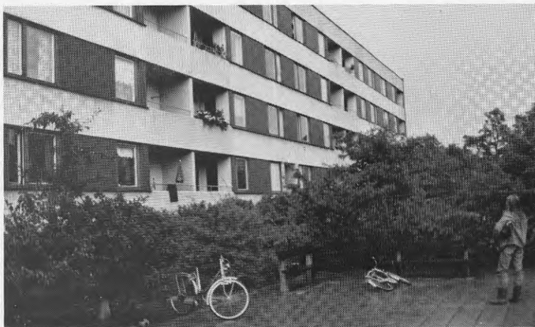
Figur 5.1.12 a. Tulpanen. Fasad före åtgärd.
