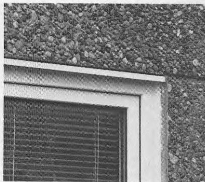
Figur 5.1.7 d. Nytt fönster. Detalj anslutning mot fasad med droppbleck i överkant...
