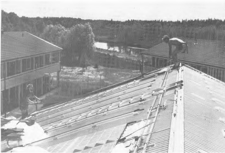
Bild 2 Montering av absorbator.
