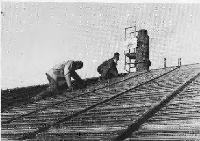
Bild 3 Akrylglasskivorna infästs med hjälp av en EPDM-gummilist.
