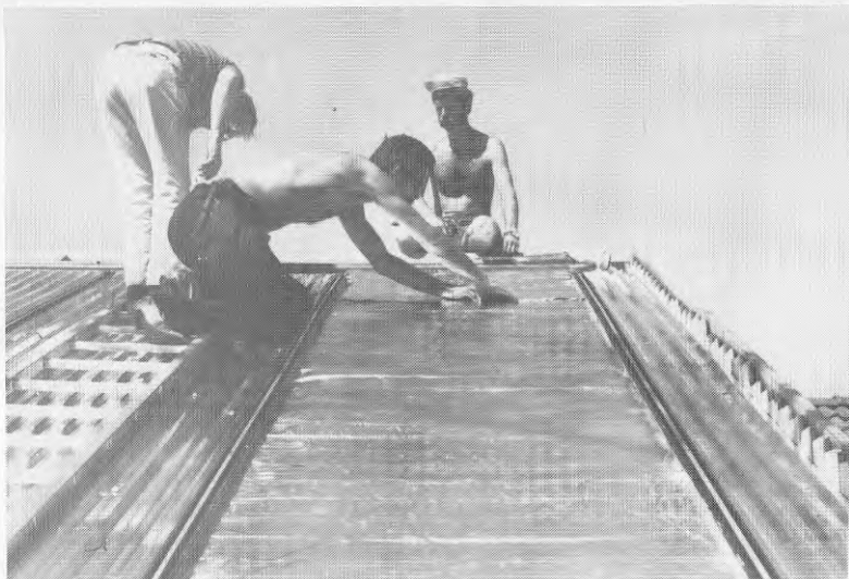
Bild 1 Utläggning av mineralullsmatta.
