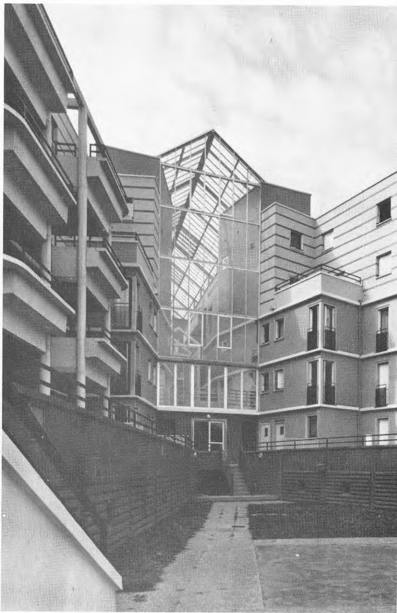
RUE ETIENNE DOLET, vy från gårdssidan över den övertäckta gatan.
