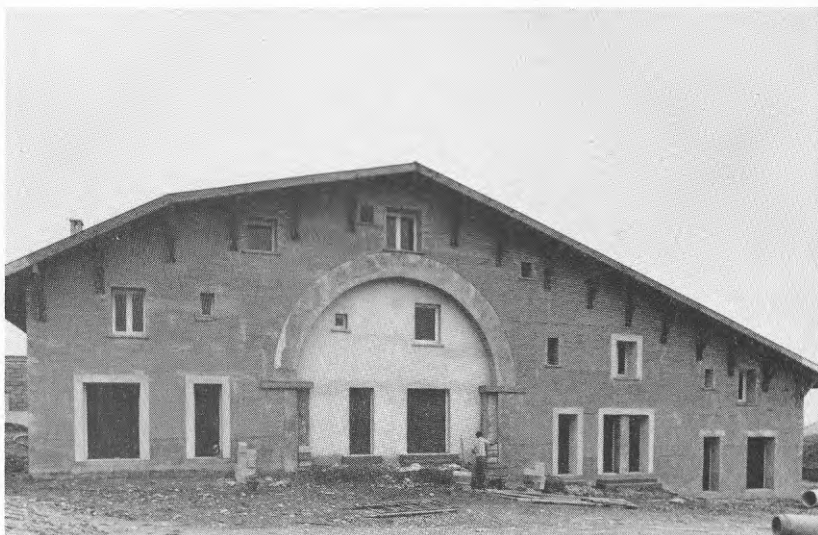
VILLAGE TERRE, l'Isle d'Abeau, Lyon - ett intressant initiativ till förnyelse av jordbyggnadsteknik.
