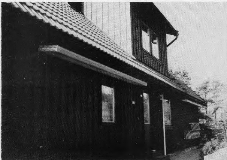
Fig 3.2 Flänsbatteris placering under takutsprång
