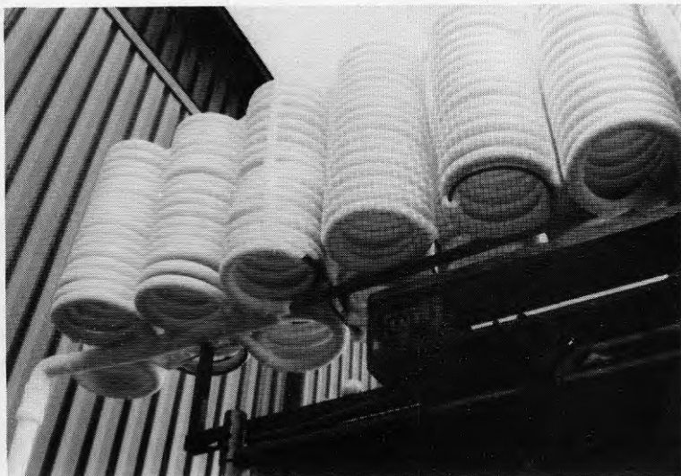
Fig B3.9 Avfrostning av cylinderstaket. Initialskedet.
