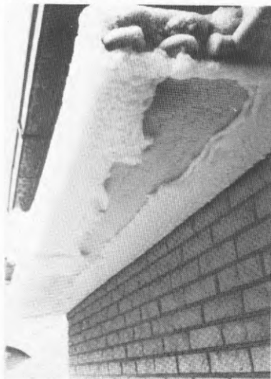
Fig 3.10 Flänsbatteri - påfrysning 4
