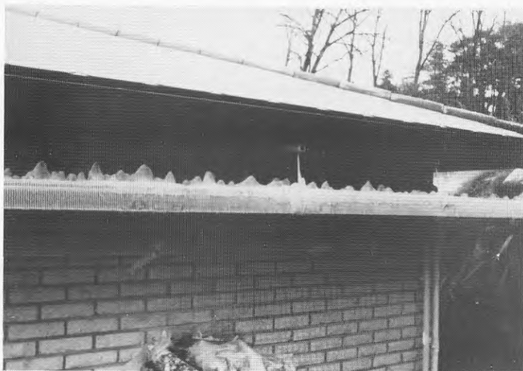
Fig 3.12 Isproblem hos konvektor monterad för nära takränna.
