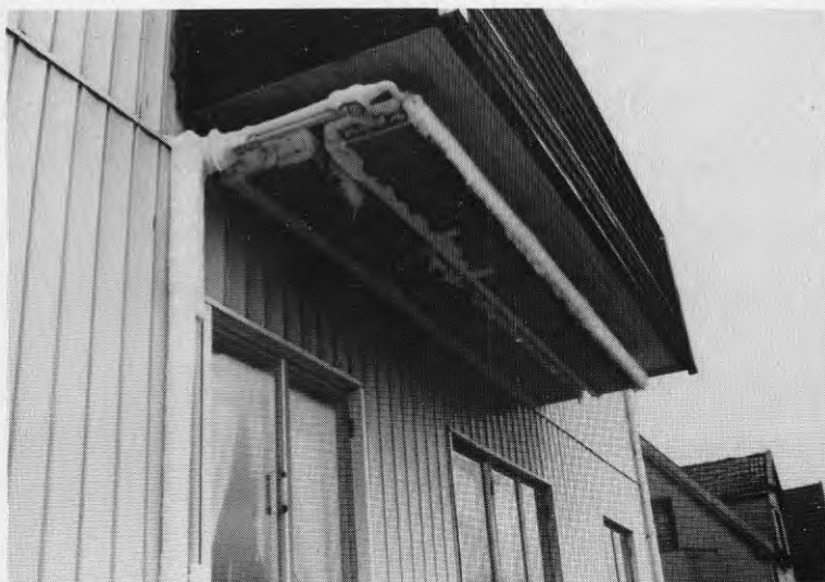
Fig 3.8 Flänsbatteri - påfrysning 2
