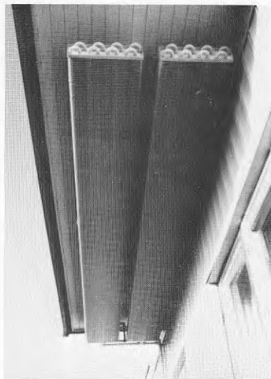
Fig 3.4 Flänsbatteris placering under balkong
