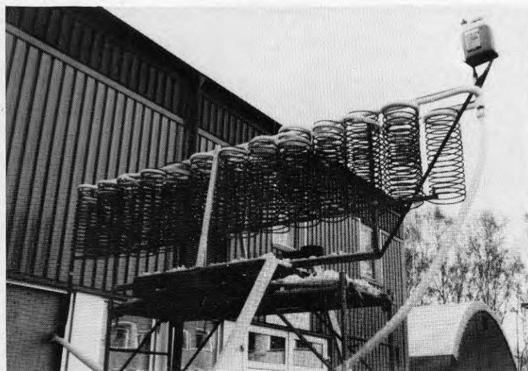
Fig B3.14 Avfrostning av cylinderstaket
