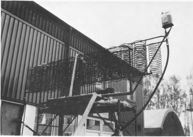
Fig B3.15 Avfrostning av cylinderstaket
