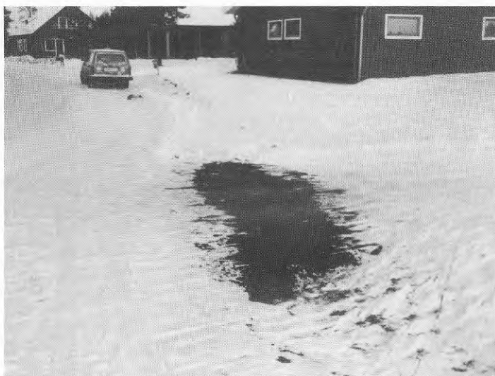
Fig 3 Avsmältning av snö på vägbana som korsas av huvudledning till fjärrvärmenät (Umeå, mars 1983).
