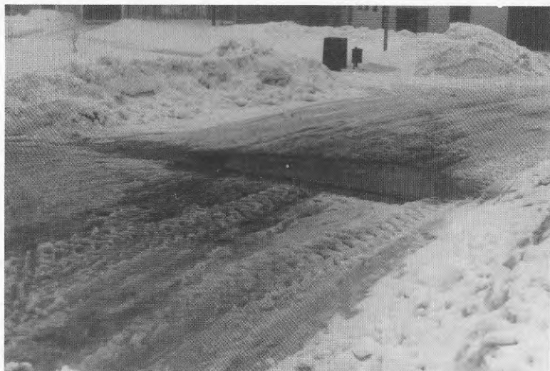
Fig 2 Avsmältning av snö på vägbana som korsas av servisledning till fjärrvärmenät (Umeå, april 1982).
