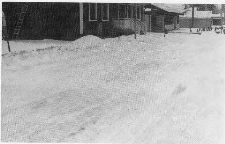
Fig 1 Svagt synlig svacka i vägbanan som korsas av ser- visledning till fjärrvärmenät (Umeå, mars 1982).
