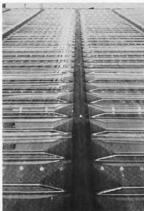
Figur 2. Integrerad solfångare med täckning av korrugerade akrylskivor.
