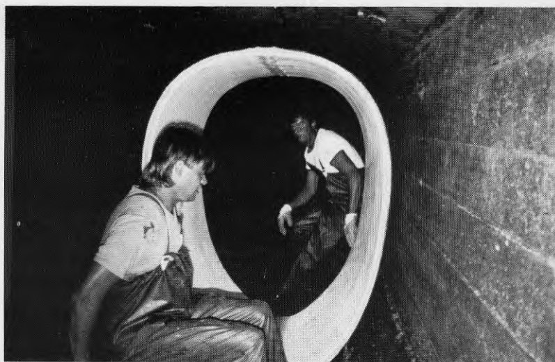
Figur 3.9.4 Montering av rörsektioner
