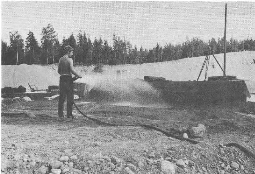
FIG. 20. Vatteninfiltration med 50 l/min över en yta 4 x 6 m.
