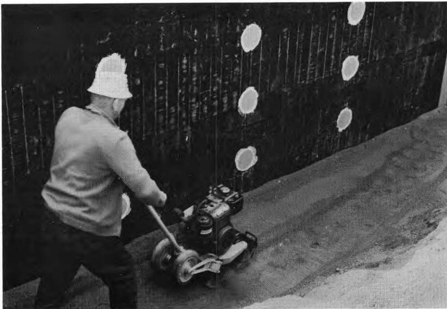
FIG. 10. Packning av sand i 20 cm lager med 140 kg vibratorplatta.
