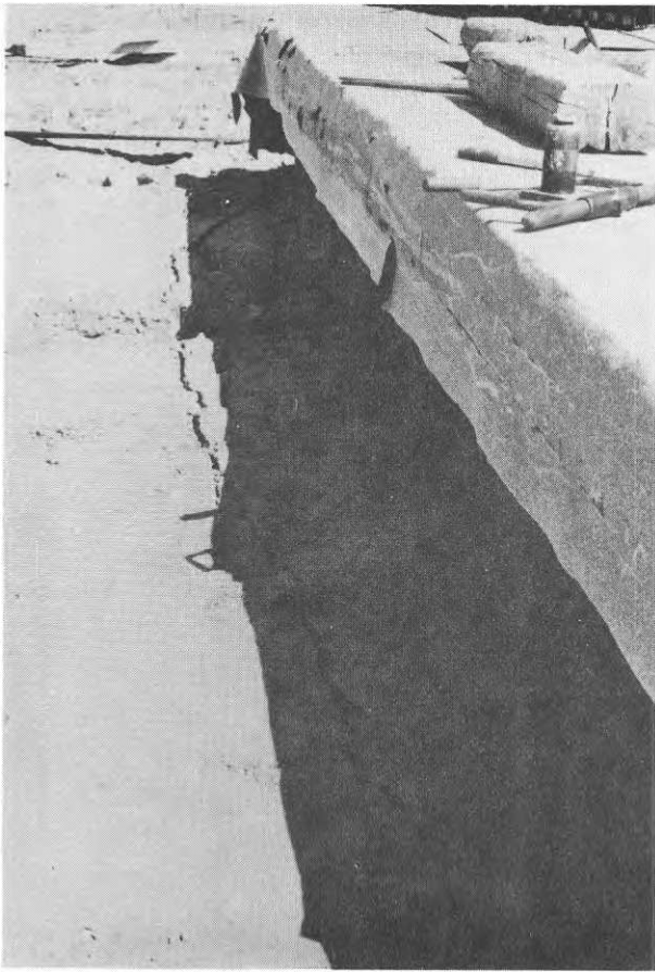
FIG. 19. Sprickbildning i löst återfylld silt efter rotation av mätväggen.
