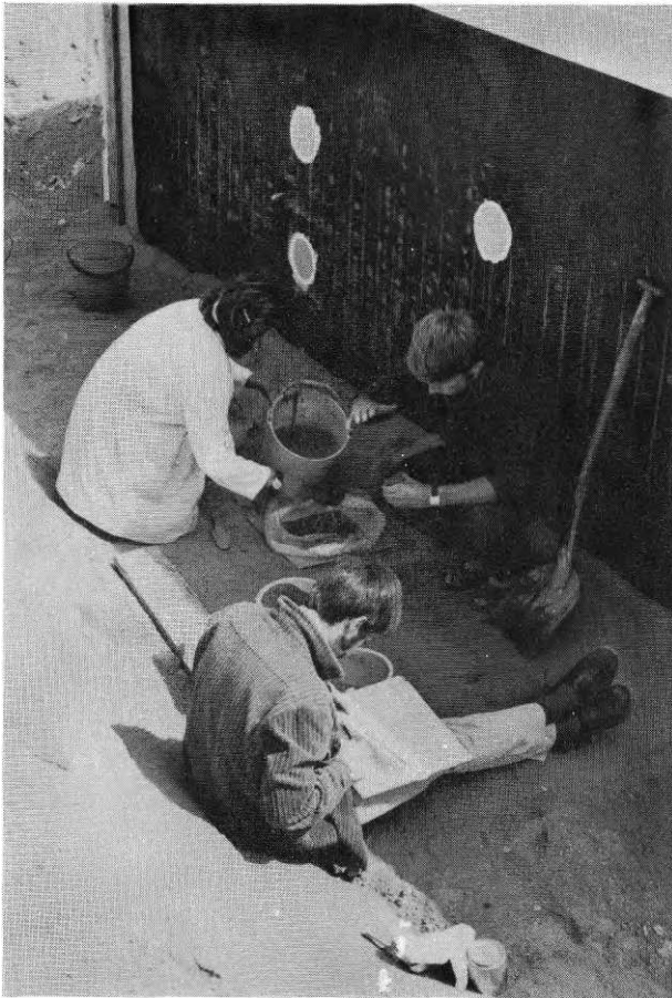
FIG. 11. Bestämning av skrymdensiteten med den s.k. vattenvolymetermetoden.
