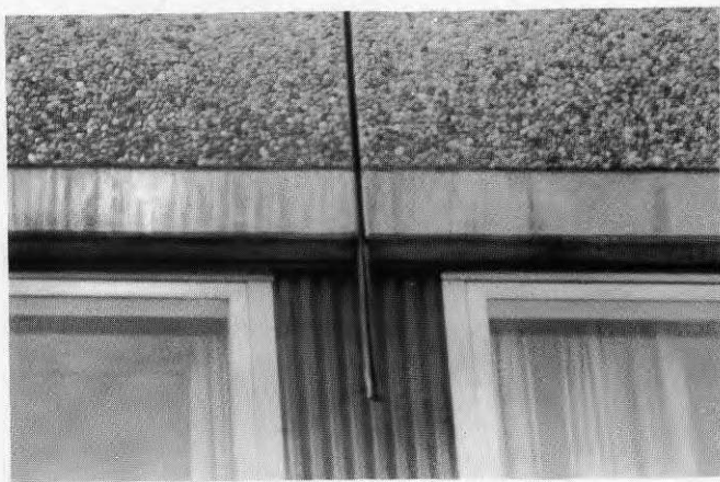
Figur 6.4 Fogningslisten har glidit ur fogen. Felaktig listdimension i förhållande till fogbredd har använts.
