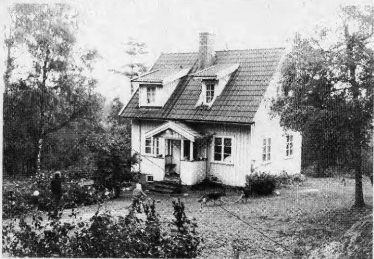
Figur 37. Åretruntbostad. Transmissionsvägar: Väggar - plankvägg, fönster, dörrar, gemensam inner/yttertaks konstruktion väggventiler. Mindre del av taket är rest såväl på husets fram som baksida, vilket höjer kostnaderna för åtgärder.
