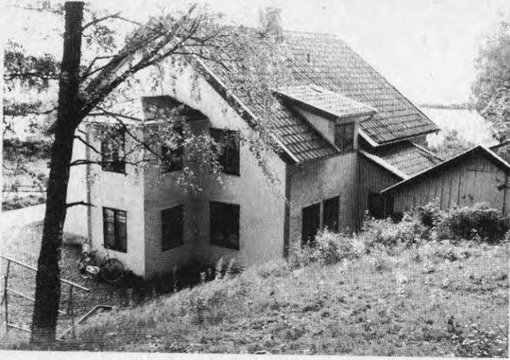
Figur 40. Äldre mangårdsbyggnad till jordbruksfastighet. Fasadkonstruktion: Revetering på timmervägg. Förslag till åtgärder. Fönster utbyts. Tilläggsisolering av snedtak i 2:a våning.
