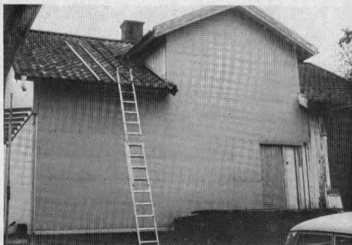
Figur 6. Husets västra fasad som utgör en begränsningsyta till mätrummet. Denna vägg har tilläggsisolerats såväl in- som utvändigt.
