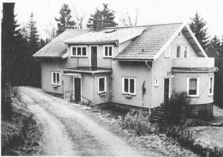
Figur 39. Stort äldre timmerhus, ca 1.5 km från banände. Åtgärdsförslag. Fönsterbyte, byte av balkongdörrar, tilläggs- isolering av fasader, plana yttertak och snedtak i 2:a våning. Igensättning av ventiler. Totalkostnad \approx 160000 kronor.
