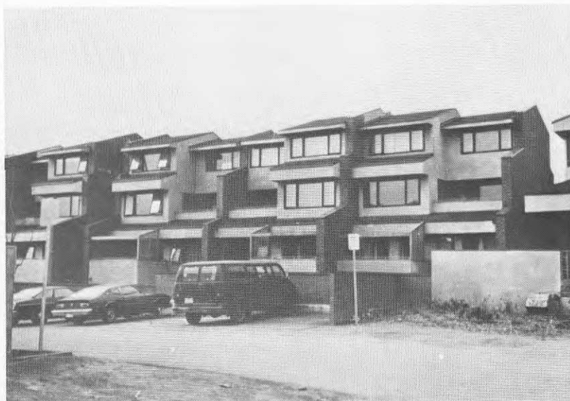
Figur 17, Radhusbebyggelse på Le Breton Flat byggt av kooperativet Laidlaw.
