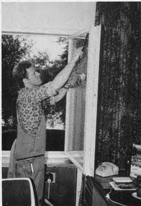
Fig 3:271 Rengöring av inåtgående fönster i kontorsrum med skviss
