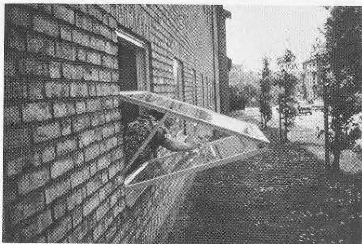
Fig 3:61 Kopplat utåtgående fönster hängt i underkant Observera den obekväma och farliga arbetsställningen för städaren
