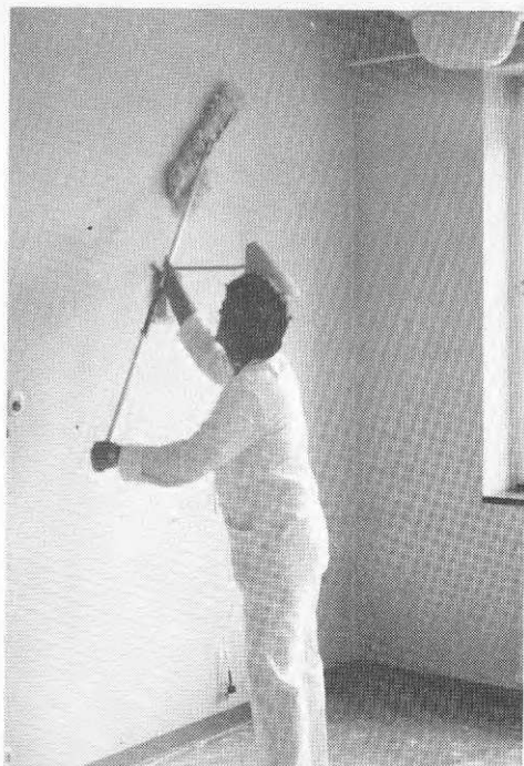
Fig 3:102 Dammstorkning av målad vägg i vård- sal Metoden används ibland när väggen inte är tvättbar
