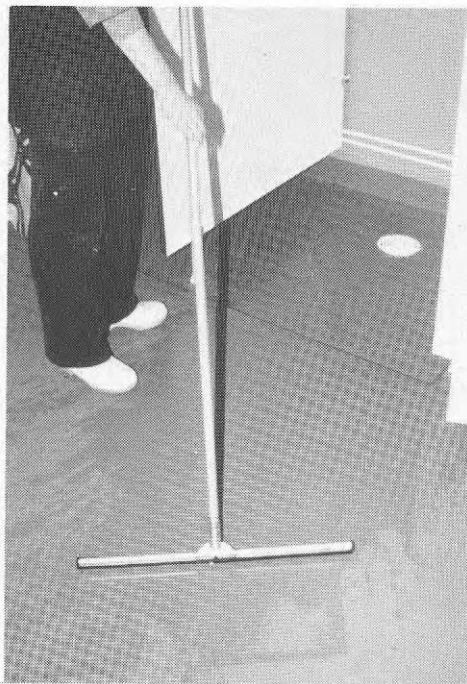
Fig 3:259 Rakning av vatten till golvbrunn i duschrum
