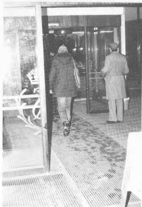
Fig 3:160 Gummilamellmatta med lamellerna i gångriktningen ger dålig avskrapnings- effekt
