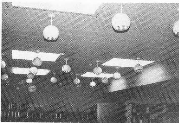
Fig 3:205 Rörliga spotlights i bibliotek Ljusarmaturer av typ "rörliga" spotlights kan vara besvärliga att rengöra därför att tvåhandsfattning erfordras
