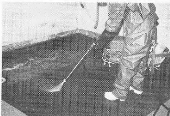
Fig 3:268 Högtryckstvättning av avpassad entrématta
