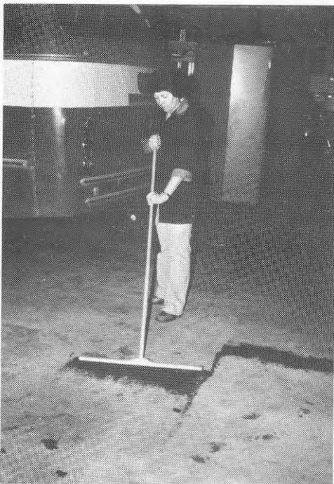
Fig 3:244 Spånsopning av betonggolv i garage
