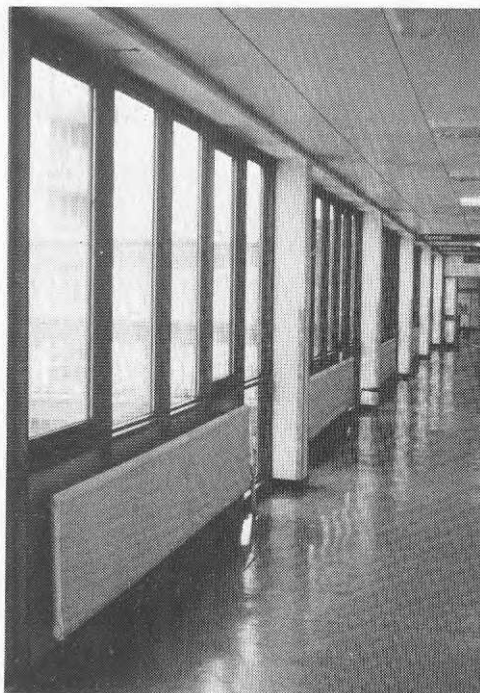
Fig 3:14 Fasadpelare i korridor Pelarna hindrar effektiv golvrengöring med kombi- maskin Kombimaskin, se fig 3:16
