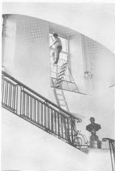
Fig 3:64 Högt planerat fönster i trapphall, interiör För att nå den övre rutan erfordras komplicerat stegarrangemang
