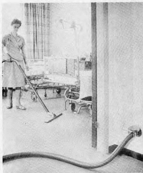
Fig 3:199 Dammsugning med centralt dammsugsystem
