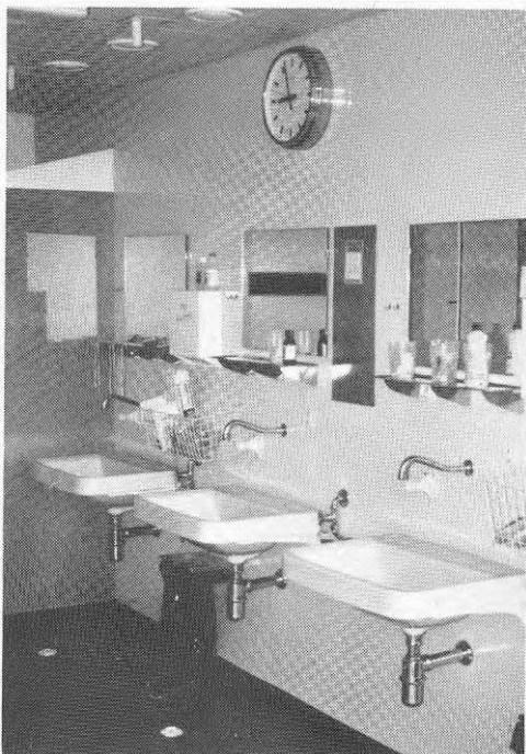
Fig 3:169 Exempel på acceptabel rördragning i tvättrum
