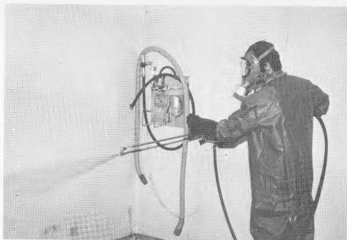
Fig 3:267 Högtryckstvättning av vägg
