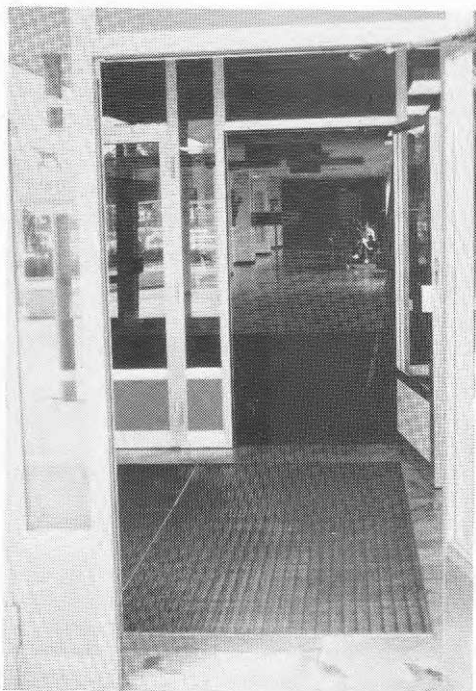
Fig 3:161 Gummilamellmatta i vindfång Mattan täcker ej vindfångets djup och bredd, varför friserna måste rengöras särskilt Dålig utformning från städsynpunkt
