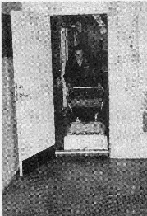
Fig 3:32 Dörr mellan städcentral och korridor Dörrens bredd tillåter knappt att en större borstvalsdammsugare kan passera
