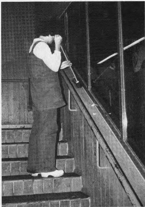
Fig 3:111 Trapphus med glasad vägg mot elevhall i skola Glaset är ocentrerat infäst mot elevhallen och det blir bara en sida av bröstningen som behöver rengöras. Bra från städsynpunkt
