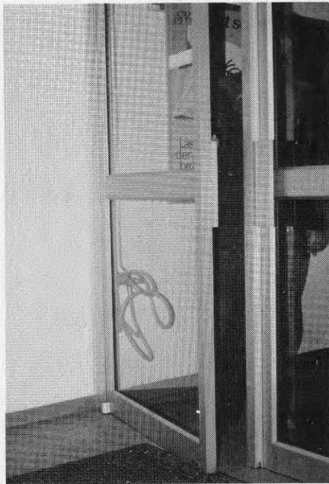
Fig 3:31 Textil torkmatta i entré Den inåtgående dörren har så låg frigång mot golvet att torkmattan ej kan placeras tätt intill dörren, utan måste läggas på distans
