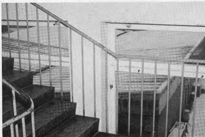
Fig 3:56 Fönster i trapphus Trapplopp och trappräcke hindrar öppning av fönster vid fönsterputsning
