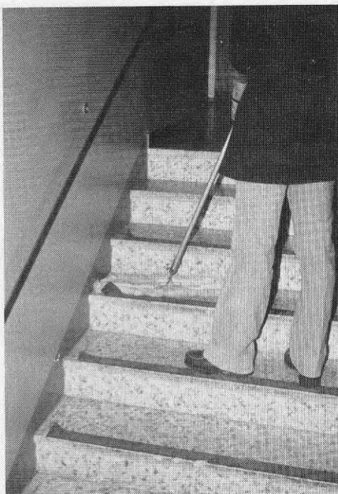
Fig 3:95 Halkskyddande remsa i trappa Moppgarnet fastnar i halkskyddet. Remsan fyller ingen funktion vid trappstegens kort- sidor
