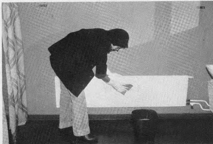
Fig 3:266 Tvättning av radiator för hand
