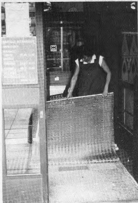
Fig 3:162 Gummilamellmatta utan botten Mattan är rullbar Observera golvbrunnen Acceptabel utformning från städsynpunkt
