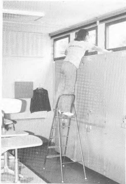
Fig 3:128 Skåp i textilslöjdsal utan takanslutning Stege erfordras vid rengöring Observera högt sittande fönster. Fönster i normal höjd finns även på motstående vägg till vänster på bilden
