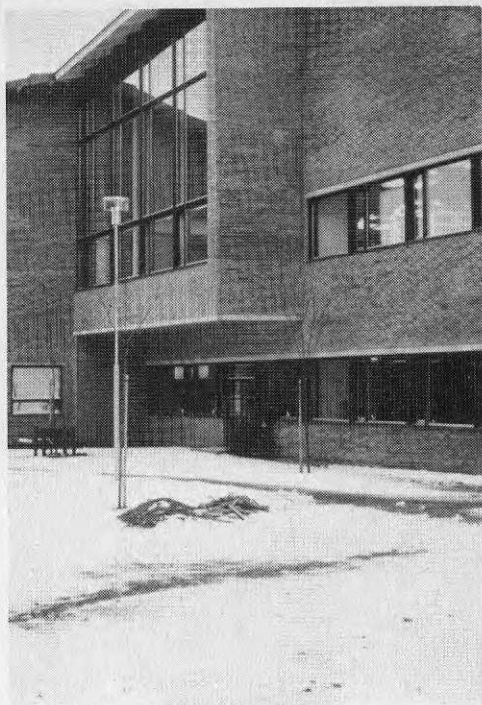
Fig 3:50 Stora fasta fönster i bibliotek Tillgänglighet för skylift-fordon endast via gräsmatta och gångväg Jämför fig 3:51 nedan, interiör
