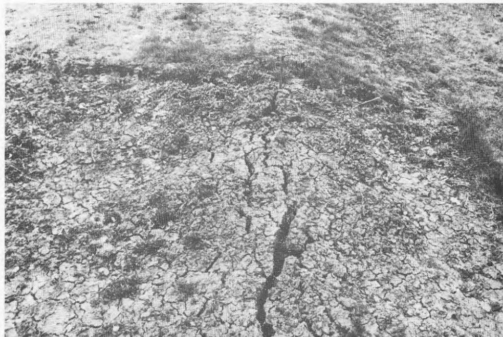
Bilden visar kraftiga sprickor i 3N-ytan den 20 maj 1980. Genom tjälbildningen har marken höjts längs slangarna och sprickor uppstått. (Roland Svensson)
