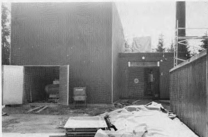
Figur 8 Värmepumpbyggnad under uppförande.
