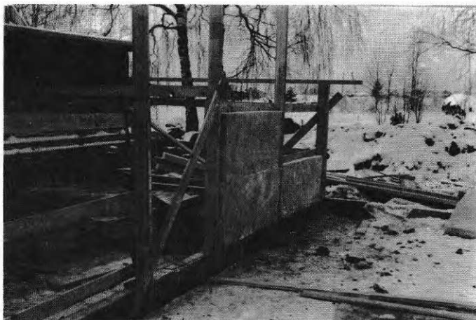
Fig. 22. Huset värmeisolerades med 10 cm mineralullskiva.
