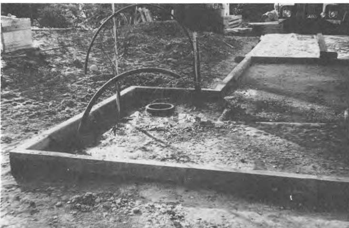
Fogarna tätades med cementbruk. Senare cementslammas hela sockeln. Vatten, avlopp, el och tele samt termoelement för temperaturmätningar utmynnade i markplanet under förrådsutrymmet.
