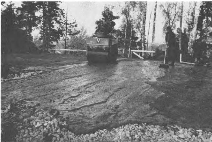
Utbredning av bruket gjordes enklast med en piasavakvast, men även vibrationsvälten fördelade bruket samtidigt som nedvibrering skedde. Det gick mycket lätt att få ned bruket i hålrummen i makadamen. Någon skillnad därvidlag mellan makadamgraderingarna 25—40 och 40—65 mm förelåg ej.
