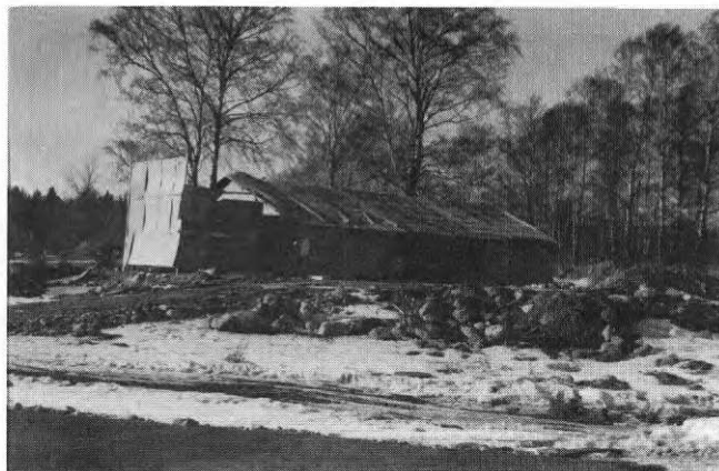
Fig.27. I börjen av februari uppfördes utvändiga solstrålningsskydd.
