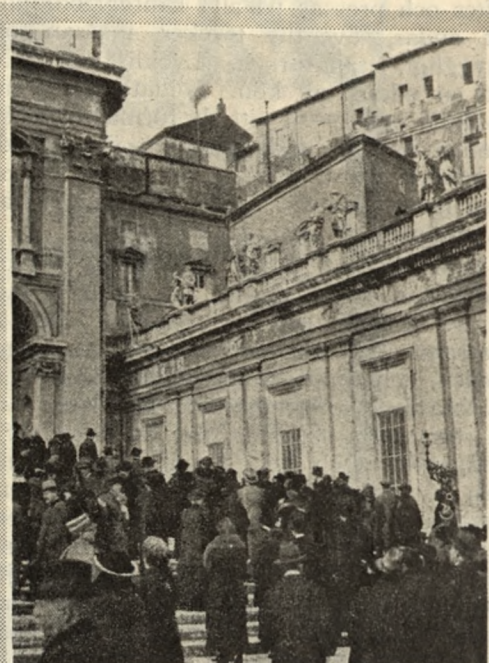
Folkmassan väntar på tecknet till att påvevalet är avgjort: röken som stiger upp ur den smala skorstenen.
