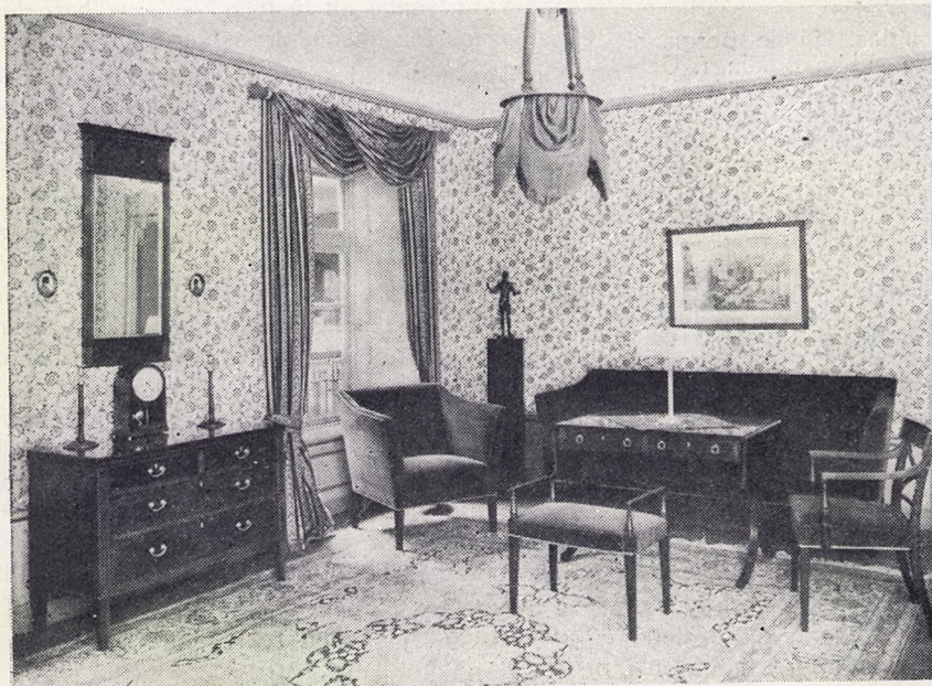
A. Broberg. Vardagsrum.
