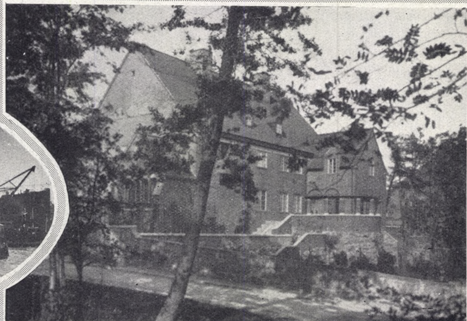
Exteriör av Carlanderska villan vid »Lyckans väg».
