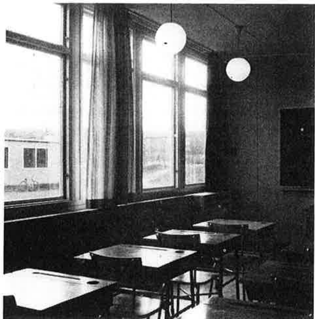
Fig. 13. Provninstallation av enhetsapparat. Inblåsningstrumma visas i närbild på fig. 16.
