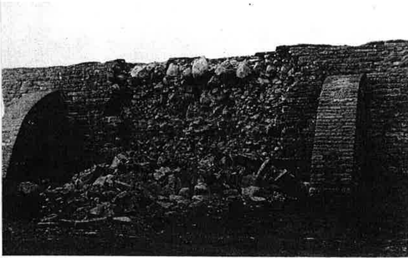
Överst: Fig. 18. Ras i april 1965 på insidan av yttre västra befästningsmuren på Kalmar slott. Bakom det yttre skal av kalksten som rasat finns en mur av blandsten och en fyllnadsmassa. Raset utlöstes av frostsprängning i den nedfuktade och av jordtrycket försvagade muren
