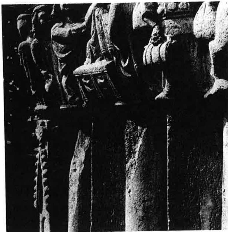
Fig. 21. Detalj av portalen på Stånga kyrka, Gotland, fig. 12. Efter omfogning med cementbruk har de runda kolonetternas rörelsemöjlighet vid temperaturändringar minskat med avspjälkning som följd. De har helt enkelt blivit »provtryckta» genom den stumma inspänningen mellan kapitälbandet upptill på bilden och basen. Ursprungliga fastsättningen bestod vanligen av enpinnar och fett, elastiskt kalkbruk
