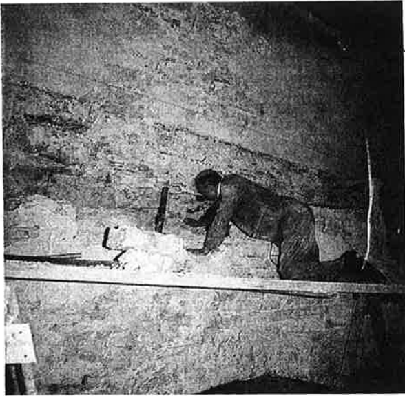
Ovan t. v: Fig. 3. Murskada i en Gotlandskyrka. Endast putsprickor och en klumpig stödpelare visade att denna medeltida skada över tornbågen existerade. Skadan upptäcktes först sedan pelaren på arkitektens order börjat rivas (!). Om arbetet fullföljts hade ett murras om ca 70 ton + västväggen varit ett faktum. Trästöttan är medeltida. Foto: Erik Olsson, Sanda. Se bil., s. 58.
