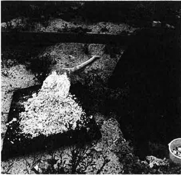
Ovan: Fig. 40. Kalkdegen i en kalkgrav kan bli mycket fast och till synes vattenfattig. Vid bearbetning blir den dock betydligt lösare och vattnigare för att i vila återta fastare konsistens
