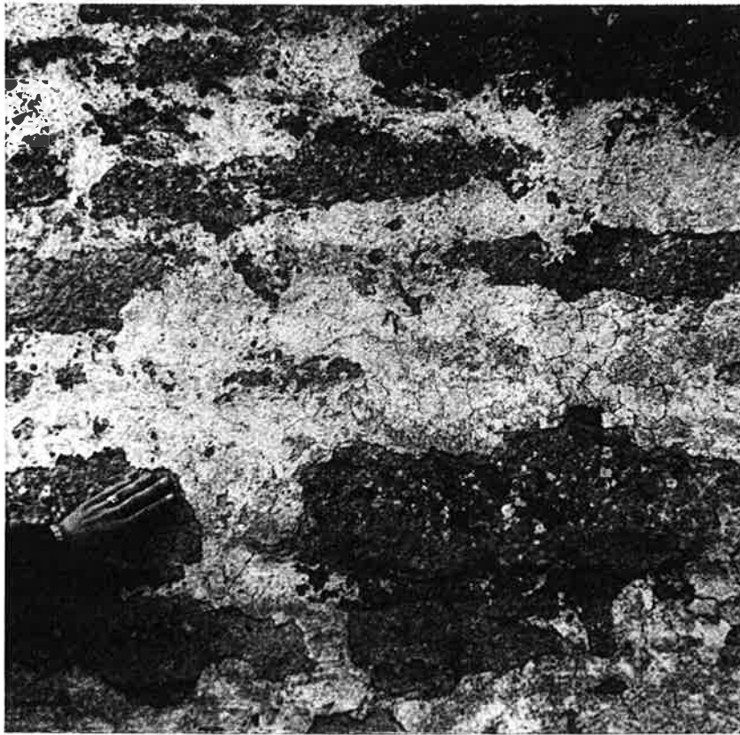
Nedan: Fig. 23. Ursprunglig puts av den typ som är vanlig på Gotlandskyrkorna. Putsen var alltid vitkalkad på en slevslätad yta, och utfördes vanligen på en mur med något utbredd fogning liknande fig. 22. Garda kyrkas kor uppfört 1325–1330. Konservatorn på bilden blottar dekorerad sten, som återanvänts, från den tidigare korabsiden, troligen uppförd på 1000-talet. Den inåt vända, putsade ytan på stenen kom vid ombyggnaden utåt med målningar och allt, och putsades över. Se även fig. 36. Foto: Erik Olsson, Sanda
