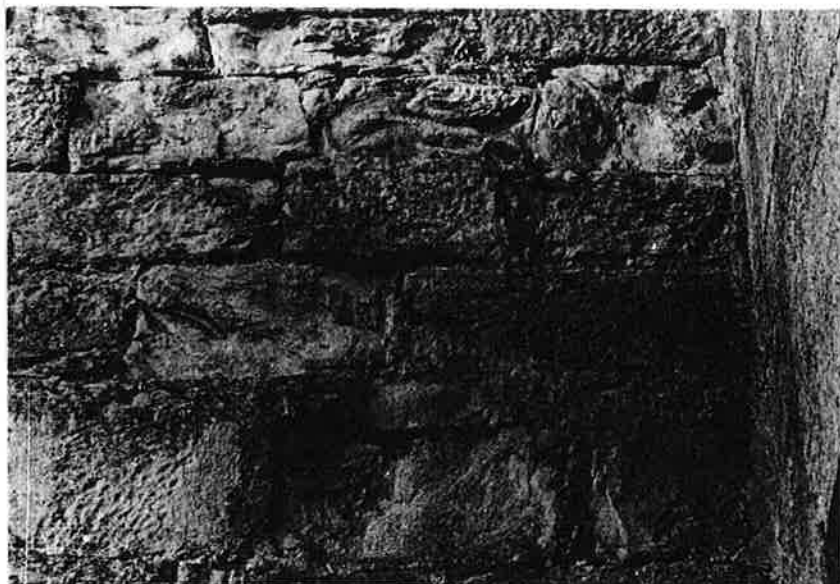
Ovan: Fig. 15. Stenvittringen är ett svårt problem, inte minst då den drabbar hela fasader. Detalj av sydfasaden på Oja kyrka, byggd av sandsten i slutet av 1200-talet. Saltvittring
