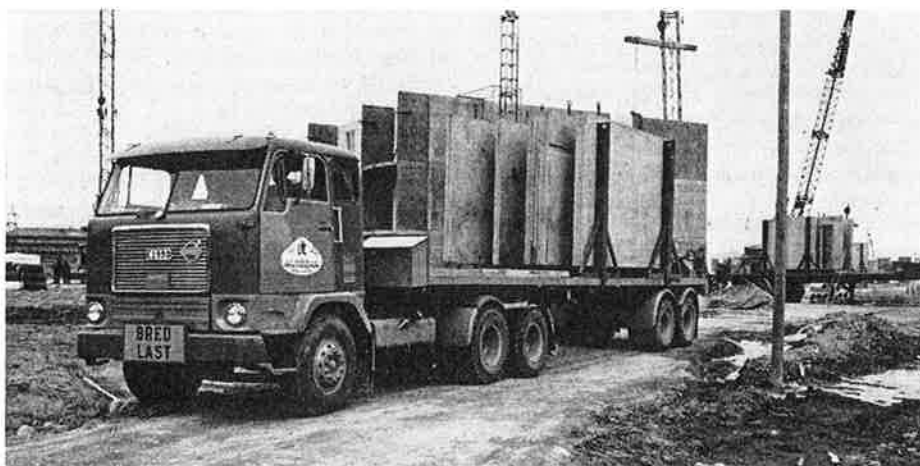
Fig 5 a, b. Bortkopplingsbara trailerflak med ställning för bl a mellanväggslement.
