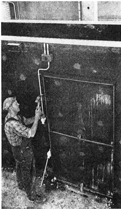
Fig 20. Applicering av plaströr mot batteriform för ingjutning (A-systemet).
