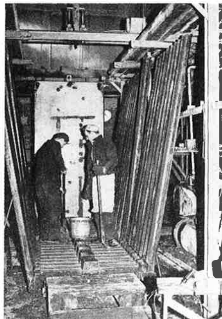
Fig 9. Formpaket för mellanväggselement under brytning.
