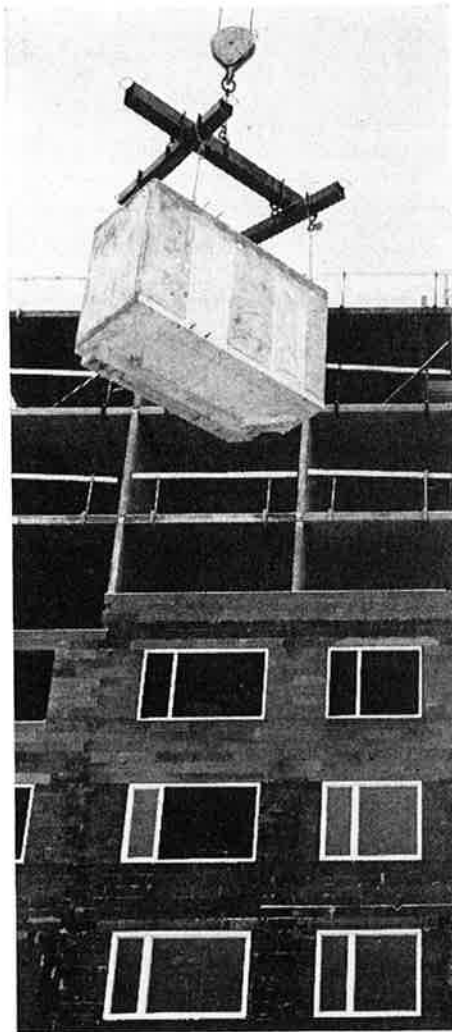
Fig 10. Montering av volymelement. Vid lyftning används ok som håller linparterna parallella.
