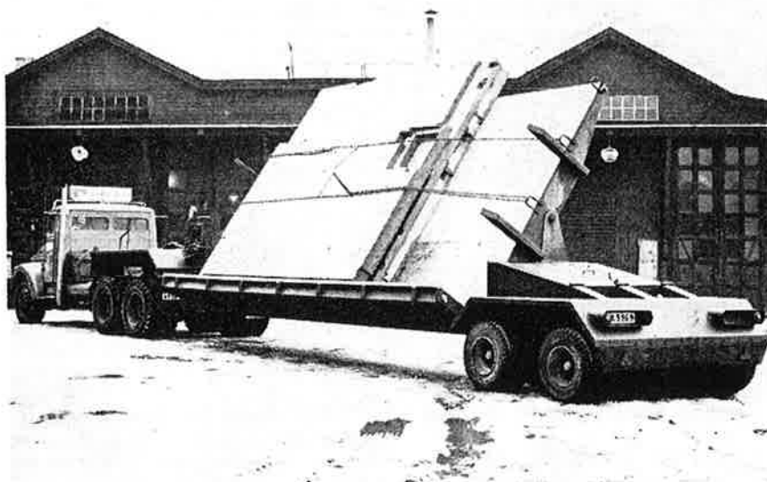
Fig 7. Transportfordon för breda betongelement.
