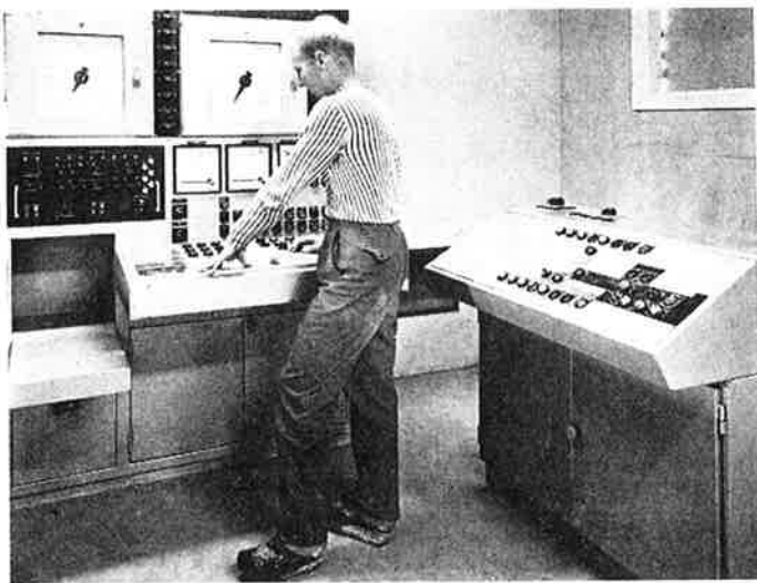
Fig 3 a. Manövercentral vid modern betongstation.
