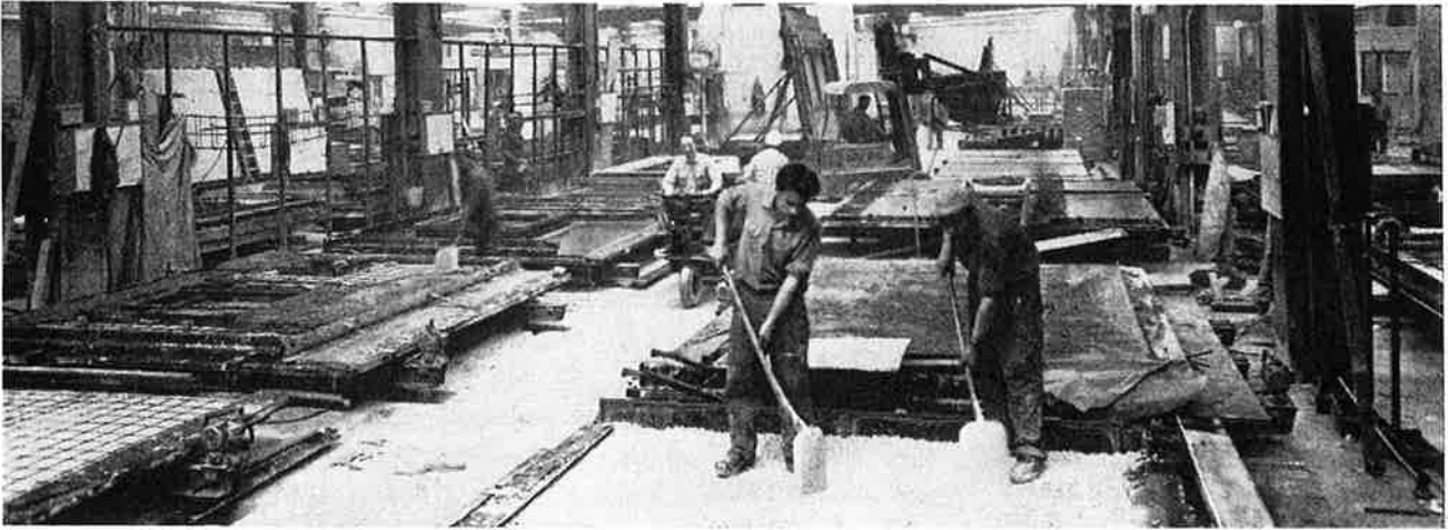
Fig 1. Tillverkning av fasadelement.
