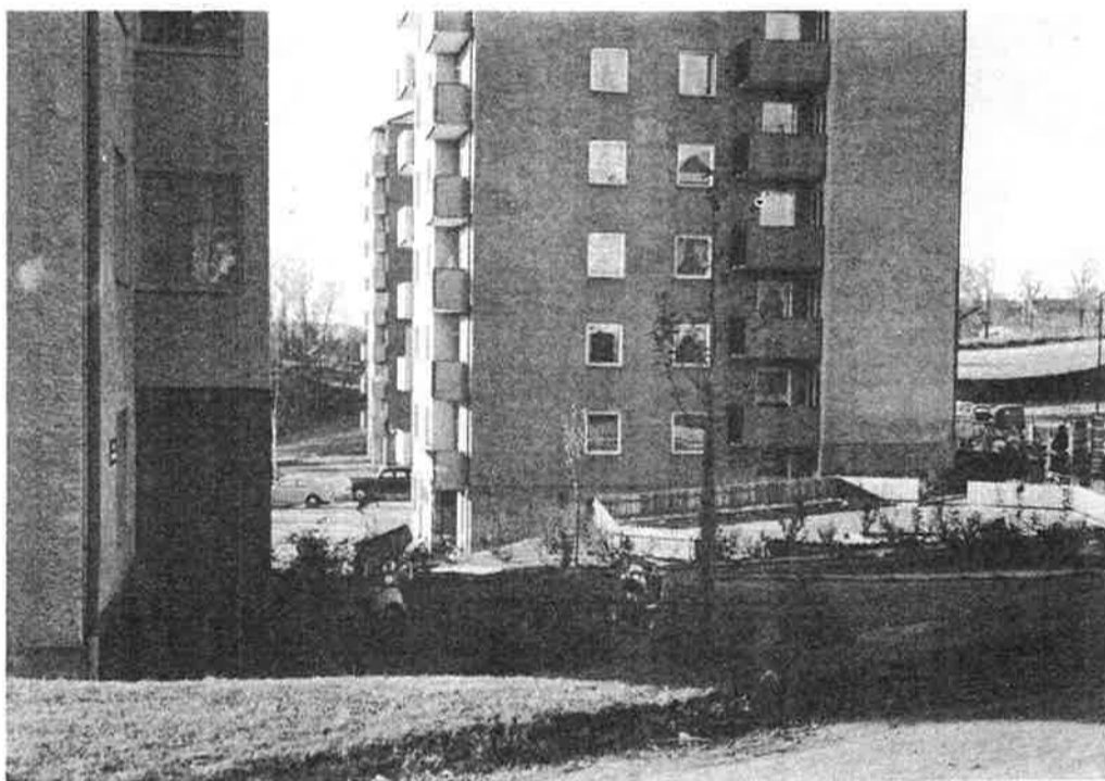
Entréerna ligger rakt mot norr. På cykelplatsen står mopeder. Mellan husen skymtar den i ett lägre plan belägna stora parkeringsplatsen.
