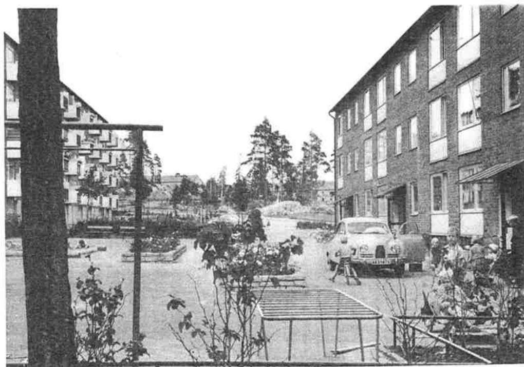
De körbara gångvägarna till husens entréer är en direkt fortsättning av parkeringsplatsens manöverytor.
