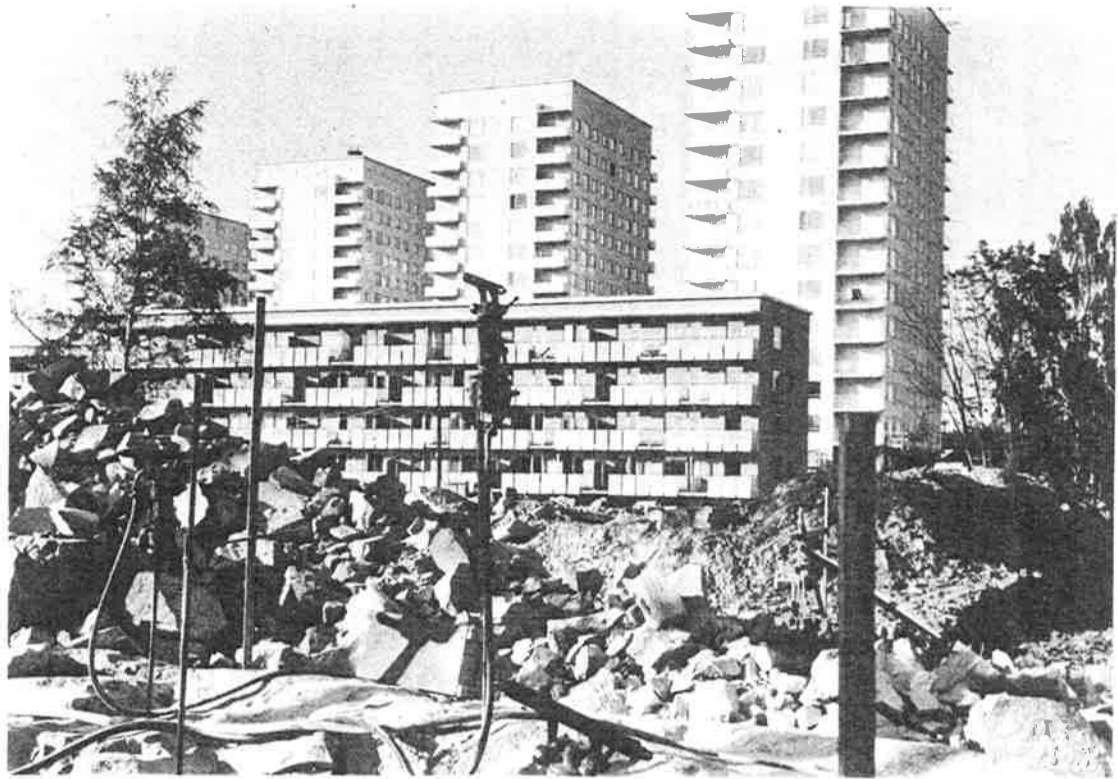
Husgrunderna längst i söder under arbete.
