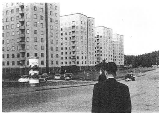
Kvarteret sett från sydväst.
