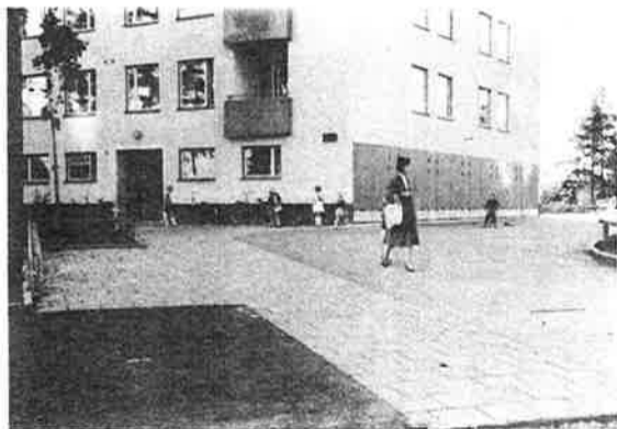
Mellan gata och entré är en gångväg markerad med betongplattor. De ligger i samma nivå som omgivande asfaltbeläggning. Det finns alltså ingen markant gräns mellan körbana och gångväg.
