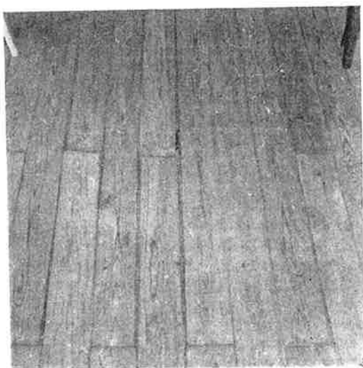
Fig. 1. Brädgolv med upp till 1 cm breda springor, som uppkommit genom att virket varit för fuktigt vid inläggningen.
