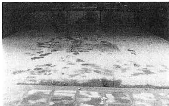
Fig. 2 (ovan) och 3 (nedan). Olämplig utformning av skrapgaller. Bilderna visar samma galler sett från två håll. Fotspåren visar att folk passerat vid sidan av gallret, som är alldeles för litet (0,5×1,0 m)
