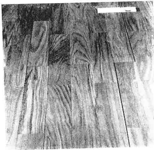
Fig. 3. Stavparkett som vid inläggningen varit otillräckligt uttorkad. Springorna är upp till 3 mm breda.
