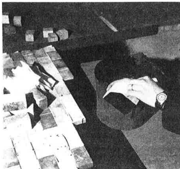
Ovan: Fig. 9. Vid läggningen fästs skumplasten längs en lång- och en kortsida av en i asfalt nydoppad kubb.
