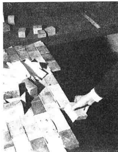
T. h: Fig. 10. Sedan skumplasten anbringats trycks kubben fast mot förut lagd kubb och den asfalstrukna betongytan.
