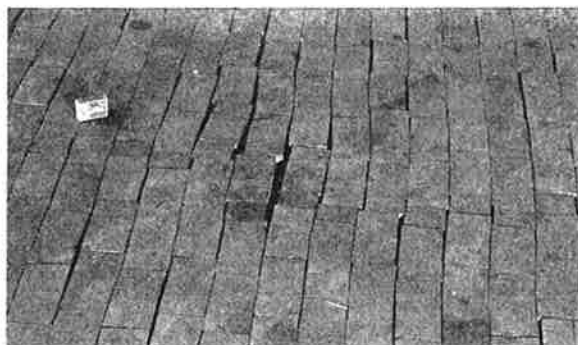
Fig. 7. Virket till kubbgolvet bör vid inläggningen ha så avpassad fuktkvot att det inte krymper när lokalen värms upp på vintern. För att undvika smutssamlade springor i golvet krävs då ofta omkring 10 vikt-% fuktkvot vid inläggning i lokaler som under drift är torra
