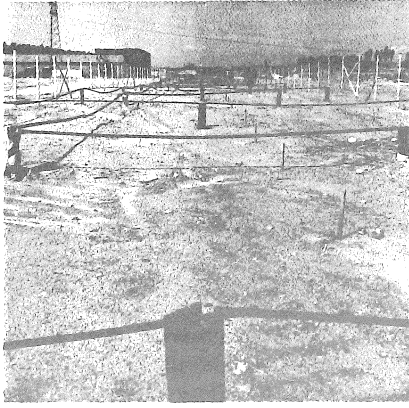
FIG. 1. Elektroosmotisk avvattning av lera under 6—7 m sandfyllning vid Scania Vabis, Södertälje. Elektrodena av järnvägsräler är förbundna i längs- och tvärvärd med armeringsjärn. Anoderna och förbindelsejärnen mellan anoderna är plastisolerade.
