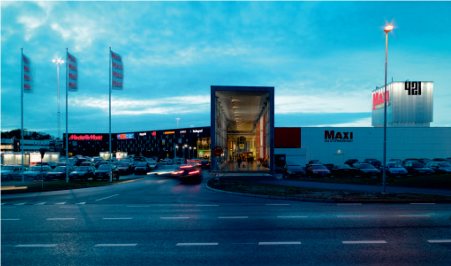
Figur 6.3 Köpcentrum 421 Högsbo, Göteborg ( http://aspelinramm.se/prosjekt.aspx?id=110&k=&s= )
