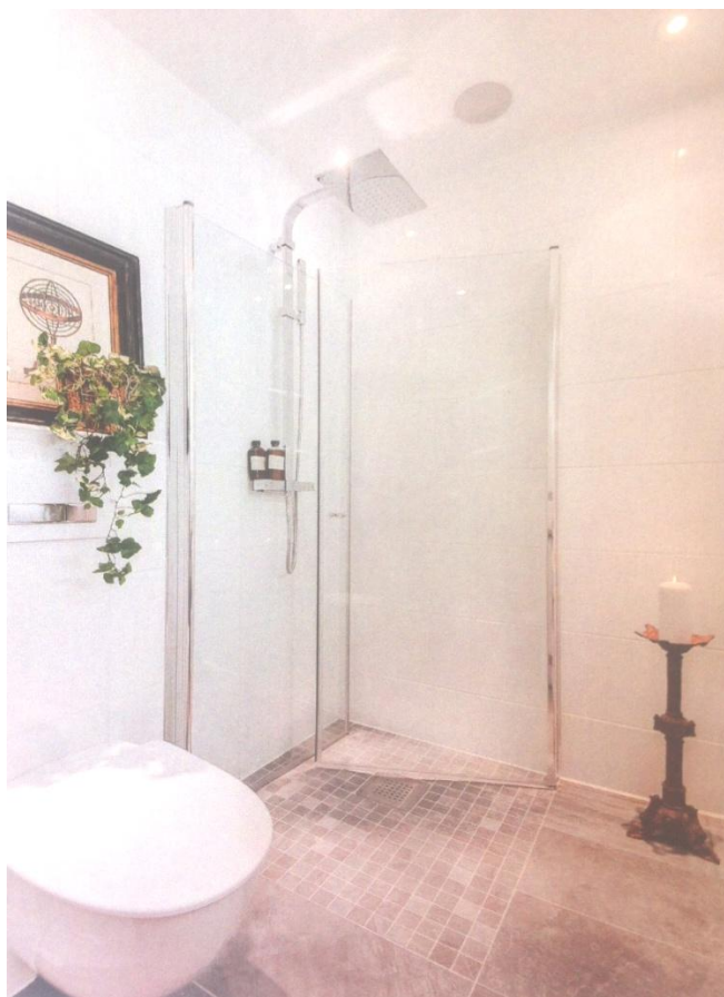
15. KULTURARVSRUTA 4. MODERNT HELKAKLAT BADRUM MED DOLD RÖRDRAGNING OCH VÄGGHÄNGANDE TOALETT. BILD: EDWARD & PARTNERS
